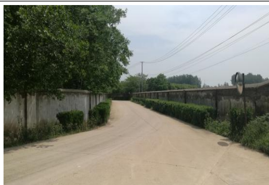
进场道路进行硬化及绿化
