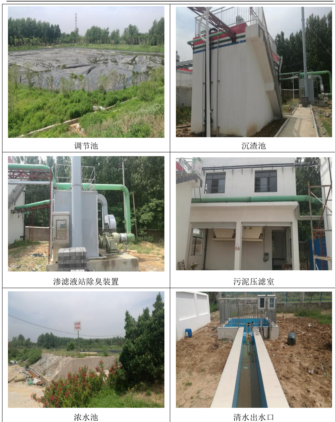
图 7.4 废水处理设施建设情况
