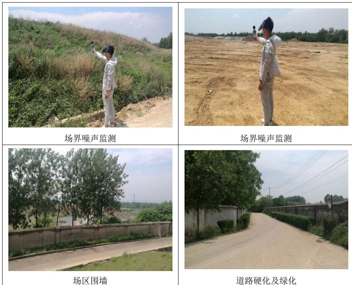
图 9-1 噪声防治设施建设
