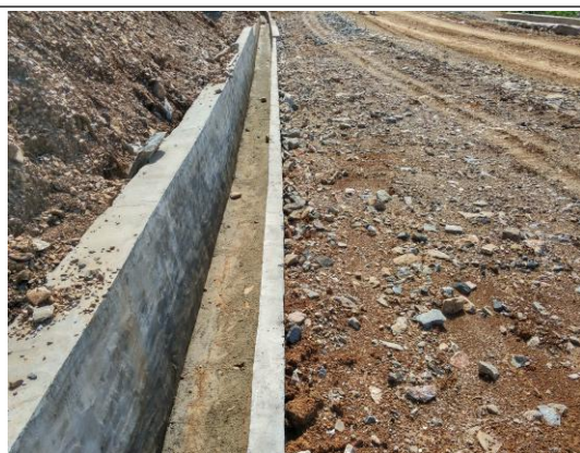
傍山侧排水沟
