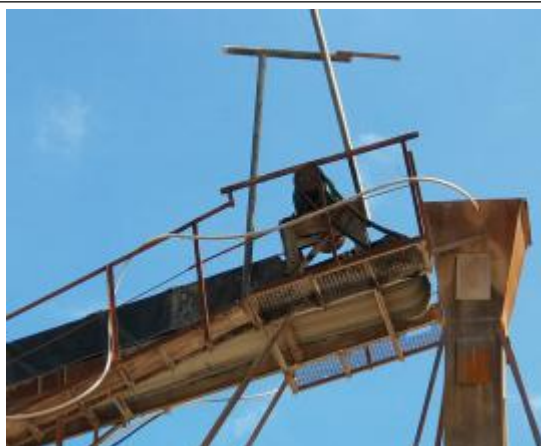
输送带安装喷淋装置
