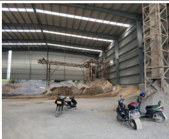
密闭式料仓储存石粉
