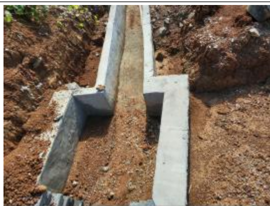
运输道路沉砂池
