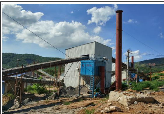
安装完成的除尘器
