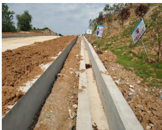
运输道路侧排水沟
