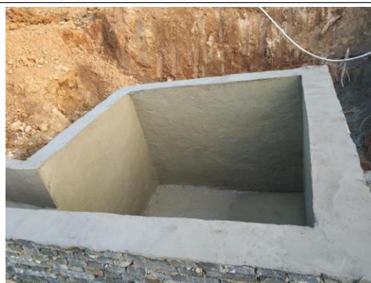
运输道路沉砂池
