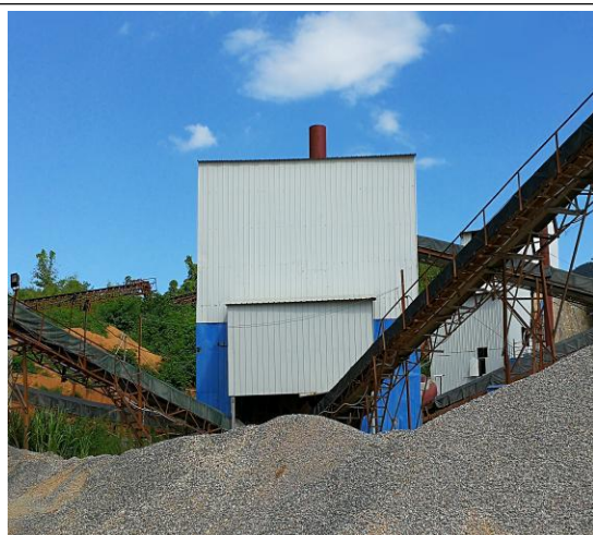
破碎站及运输廊道全封闭
