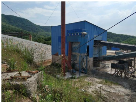
破碎加工区全封闭
