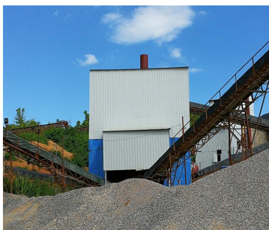
破碎站全封闭
