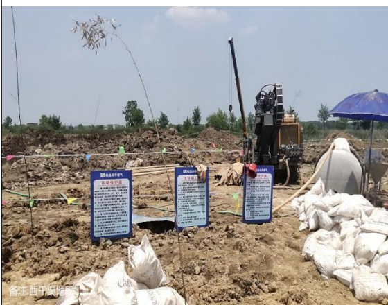
北干渠定向钻施工
