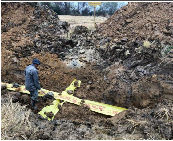
管道与川气东送交叉段完成施工
