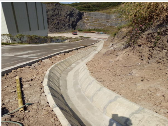
开拓运输道路旁排水沟 1
