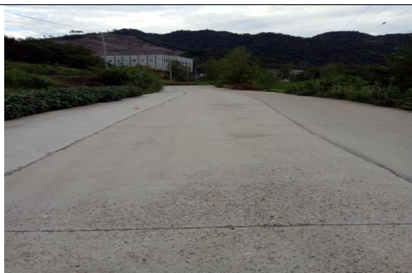
道路区（运输道路）
