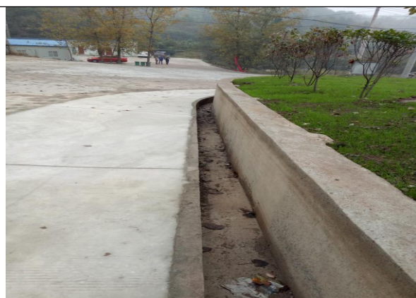
运输道路一侧排水沟
