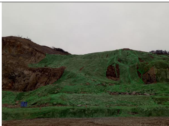
采矿区密目网苫盖
