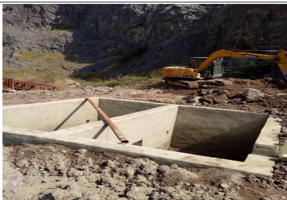
采矿区沉沙池
