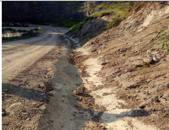
开拓运输道路旁排水沟 2
