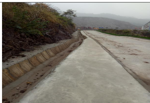
场内道路一侧排水沟 2
