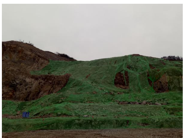
采矿区密目网苫盖
