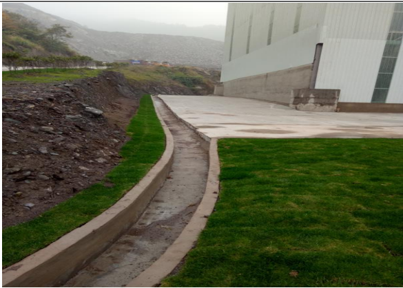
场内道路一侧排水沟 1
