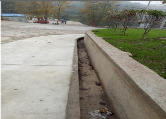
运输道路一侧排水沟
