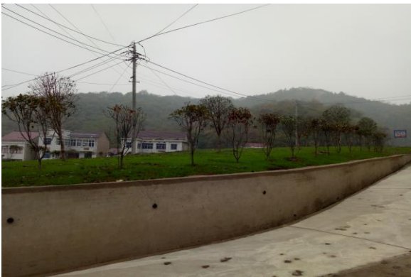
临时土方周转场
