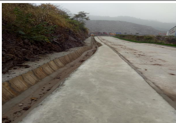
场内道路一侧排水沟 2
