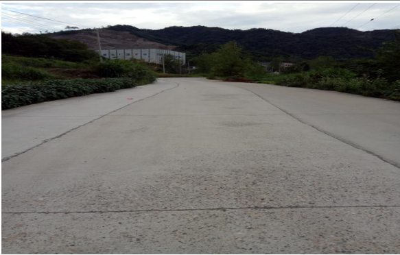
道路区（运输道路）
