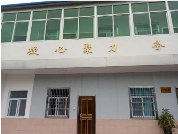
生活办公区现状 1
