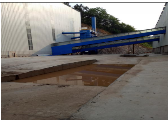
矿石加工区沉沙池 2
