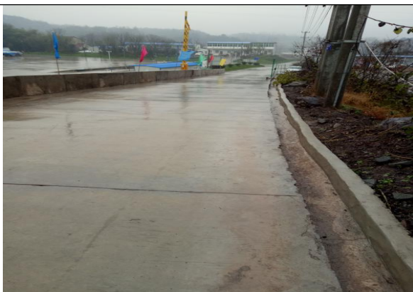
运输道路一侧排水沟
