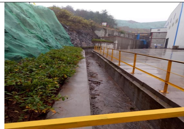
场内道路一侧排水沟
