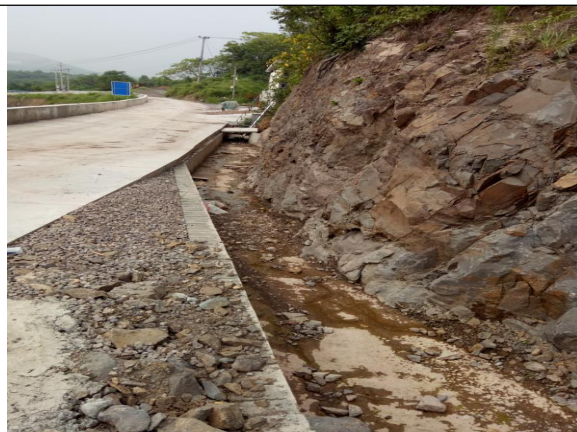
开拓运输道路旁排水沟 2
