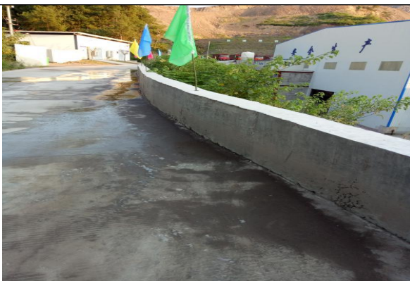
道路一侧挡墙
