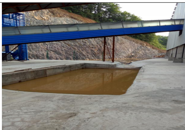
矿石加工区沉沙池 1
