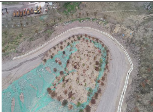
开拓运输道路旁排水沟 1
