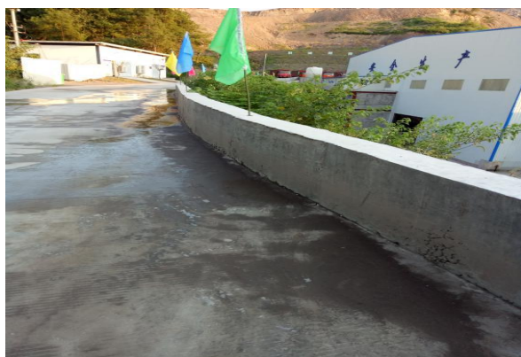
道路一侧挡墙
