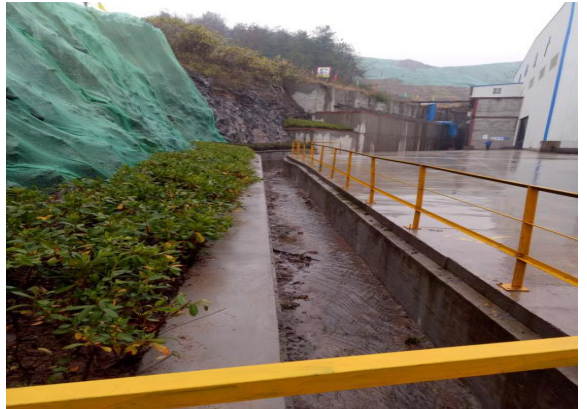
场内道路一侧排水沟
