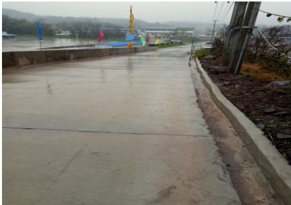
运输道路一侧排水沟
