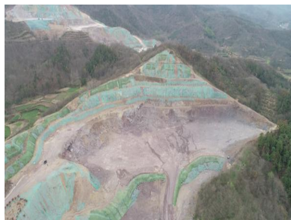
采矿区密目网苫盖
