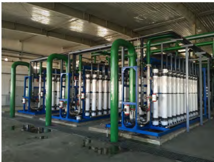
超滤装置系统示意图
