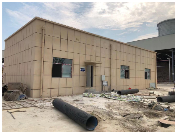
水泵房厂房隔声
