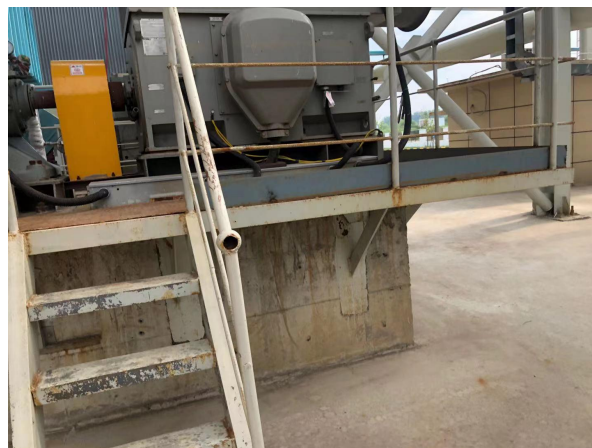
风机基础减振
