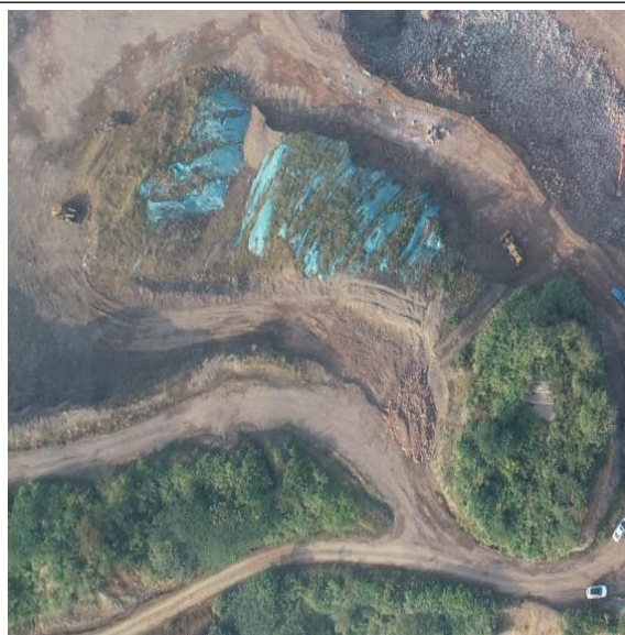
临时土方周转场
