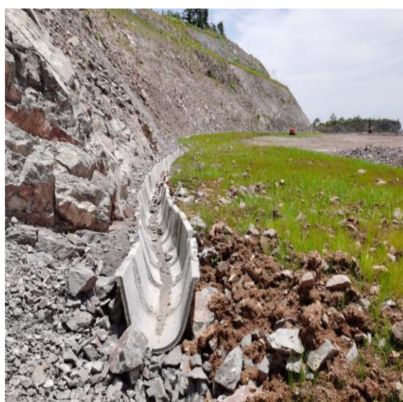
采矿区排水沟
