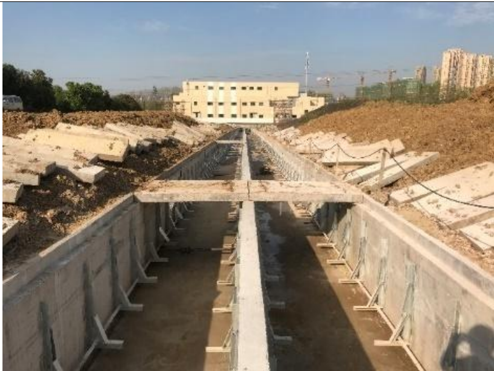
地埋电缆管沟槽施工图
