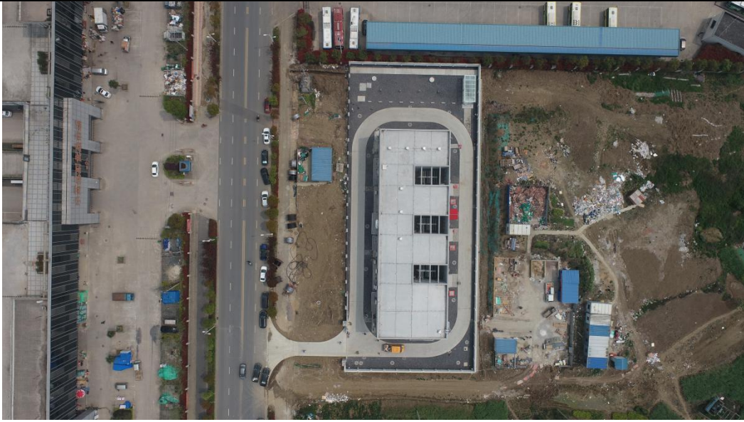
图 1.2-2 变电站现状图
