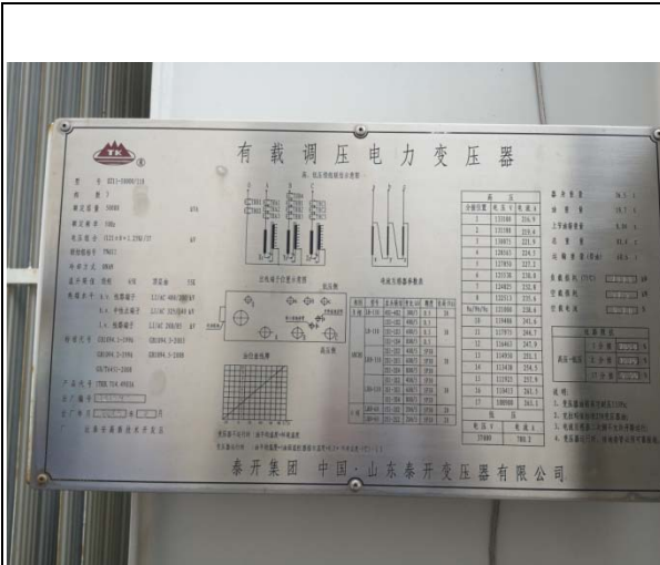
升压站 1#主变铭牌
