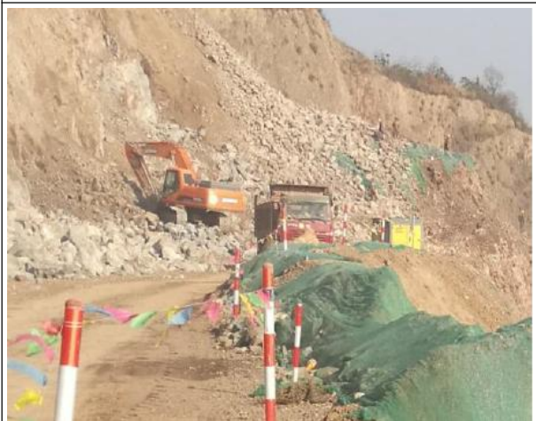
采矿台阶土石隔埂
