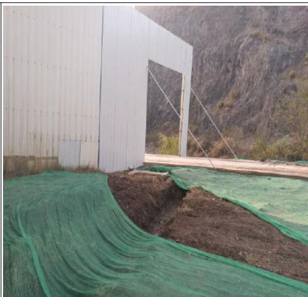
加工场区表土回覆、临时排水沟覆盖及排水
