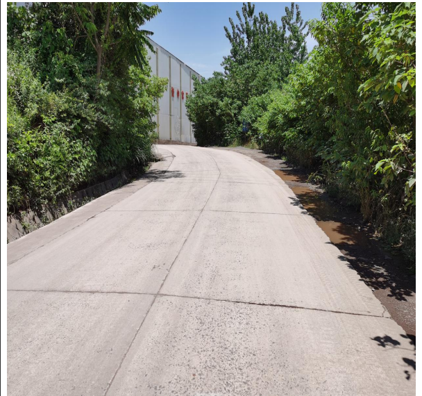
道路区（运输道路）
