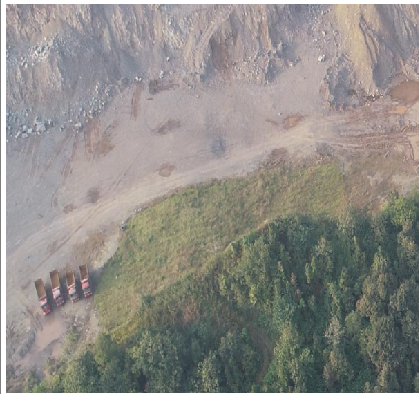
临时土方周转场
