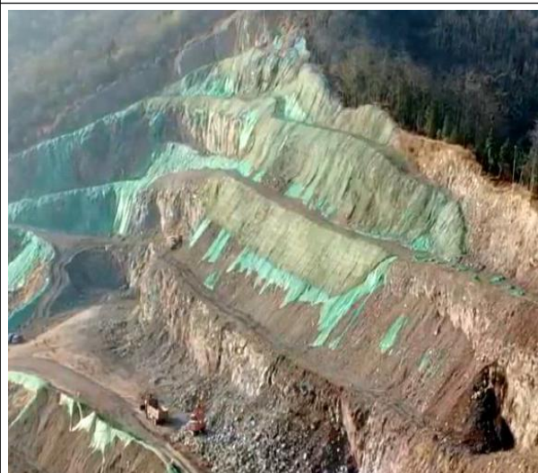
开采终了台阶筑土培坡、播撒草籽及覆盖
