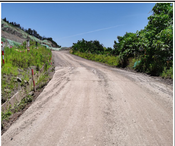
矿山道路现状
