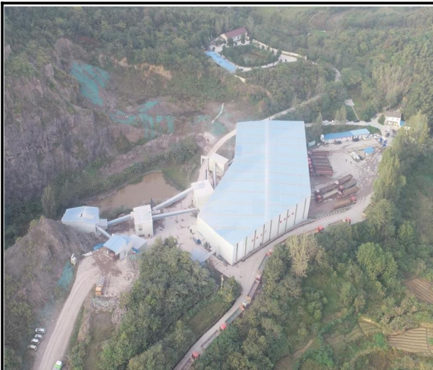
矿石加工区现状 1
