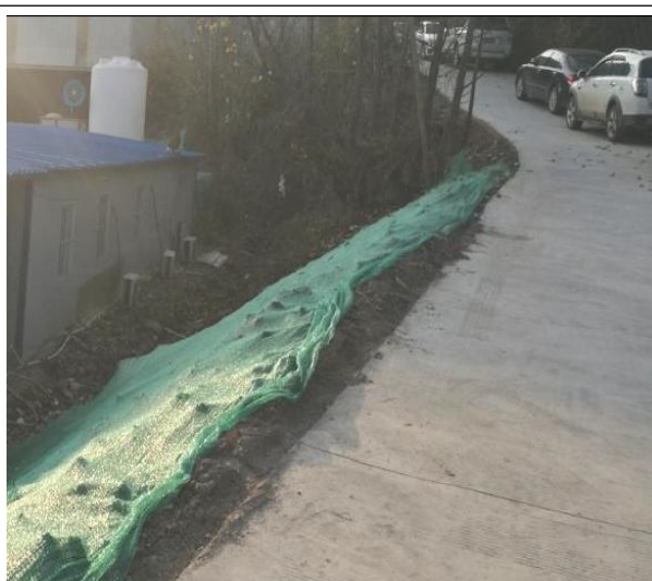
道路边坡密目网临时苫盖
