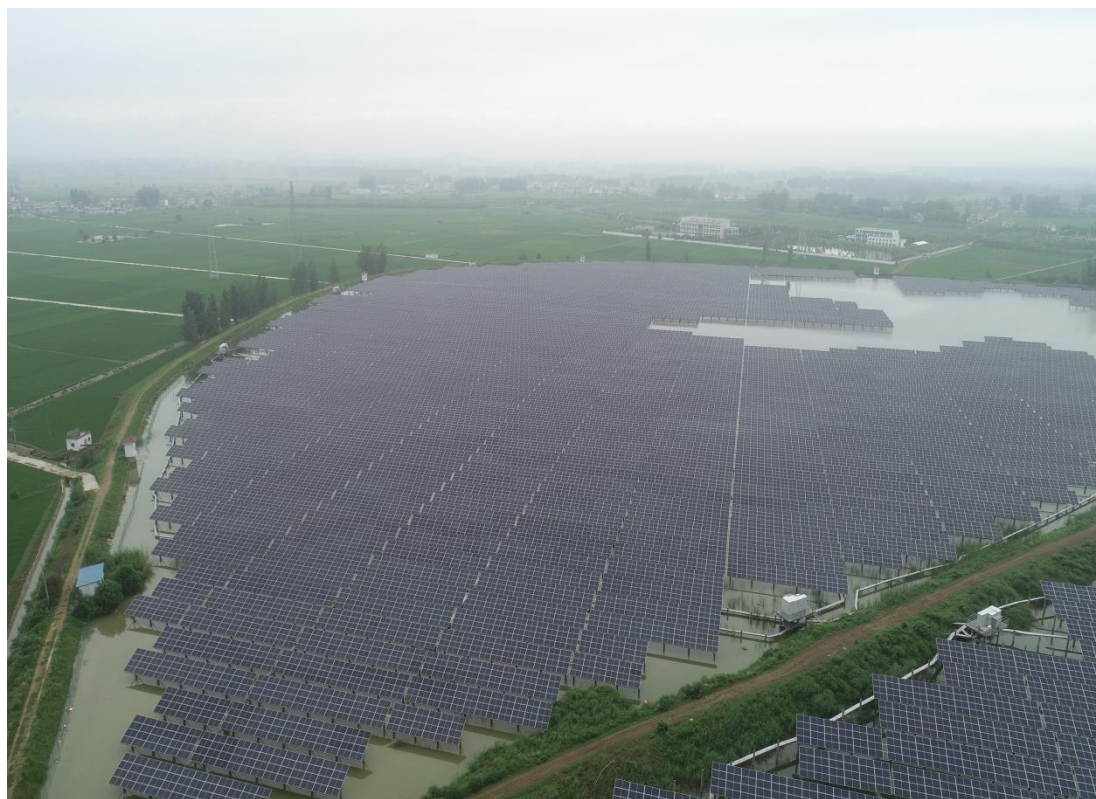
光伏场区现状 2
