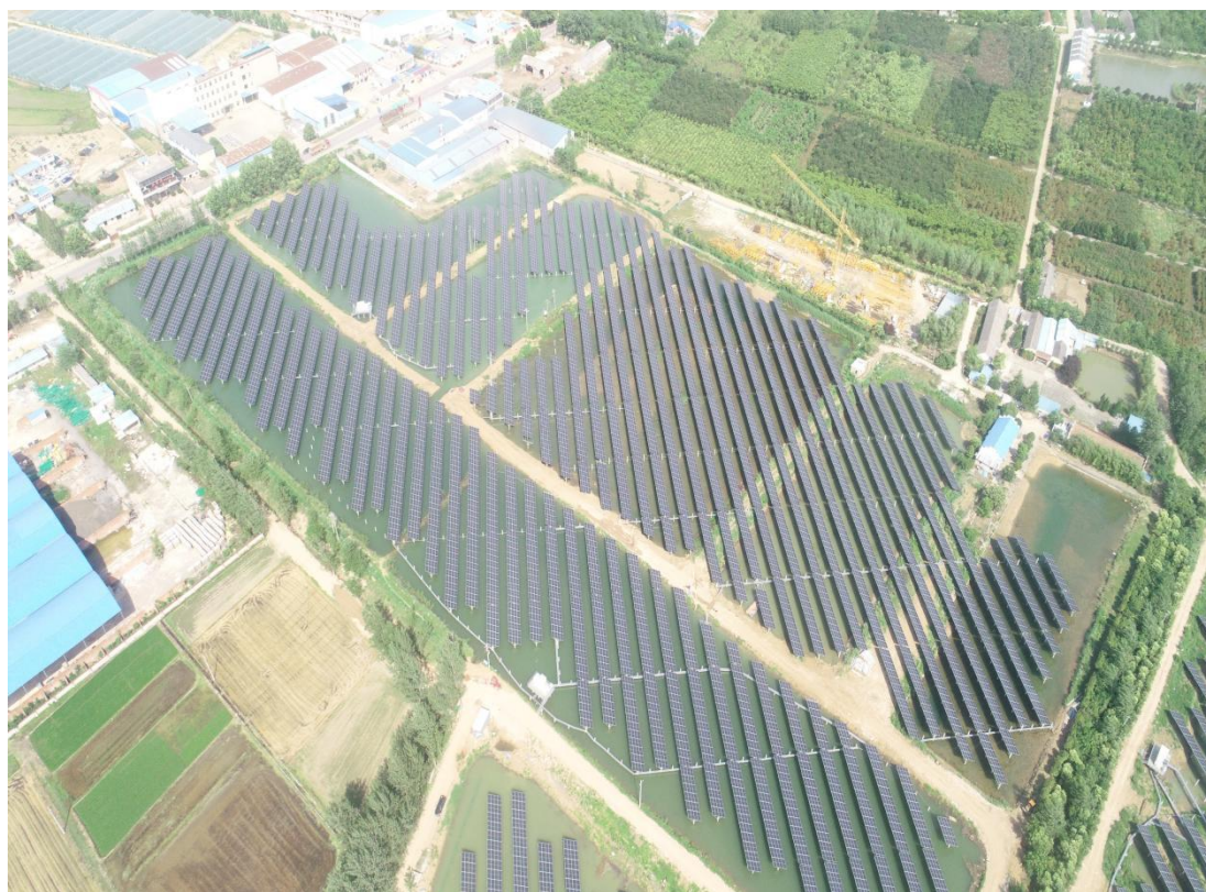
光伏场区现状 3
