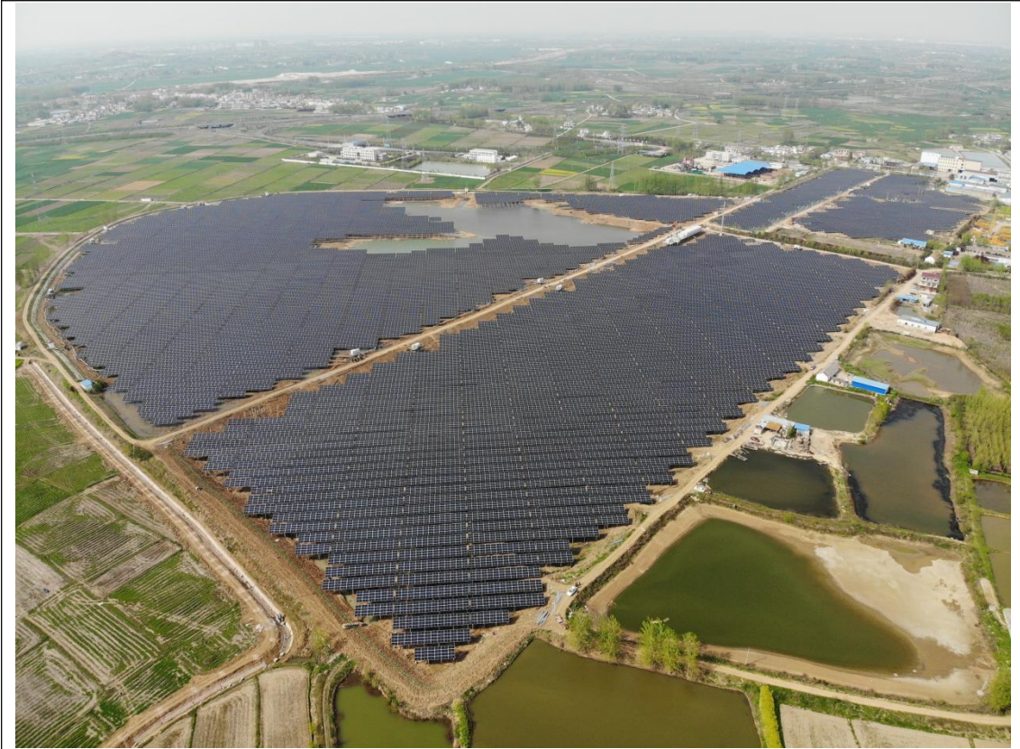
光伏场区现状 4
