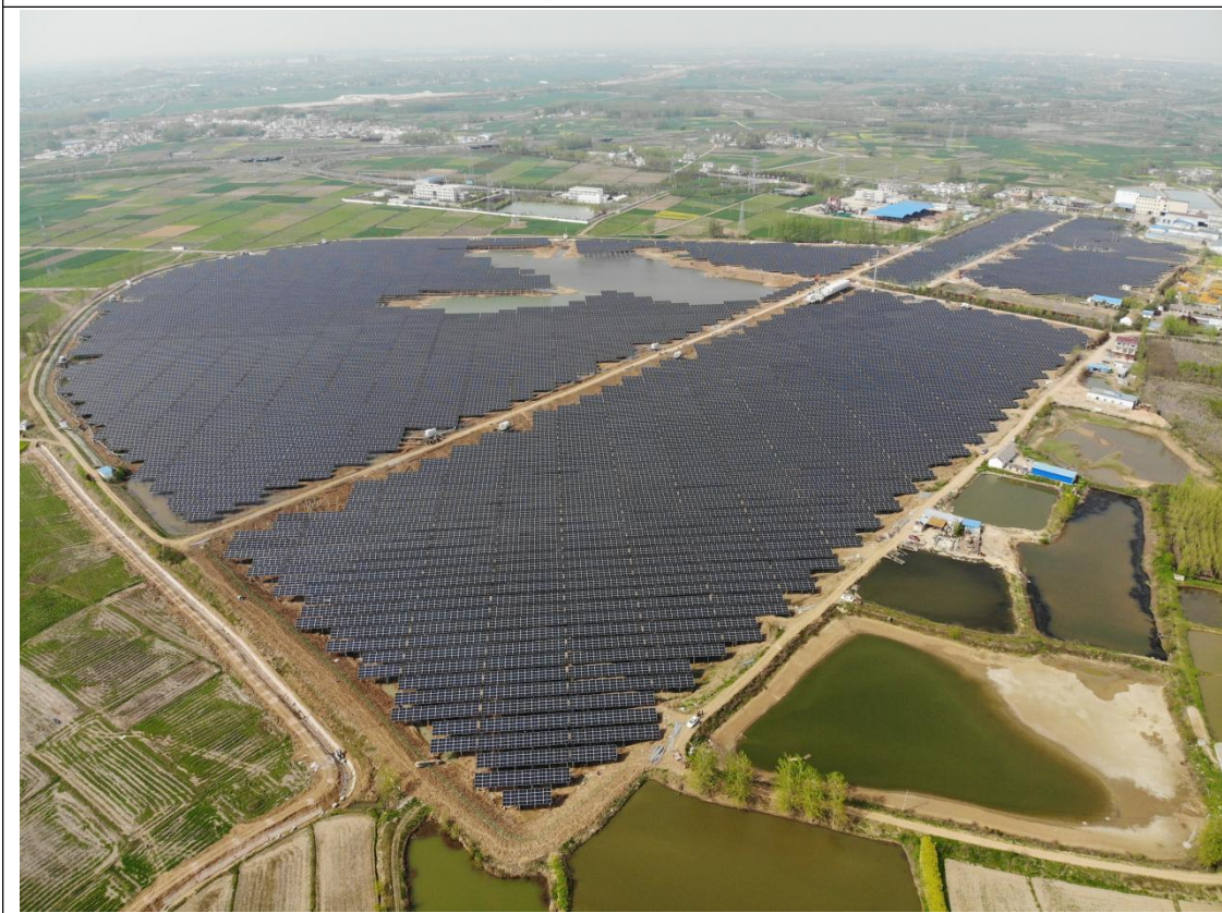
光伏场区现状 4
