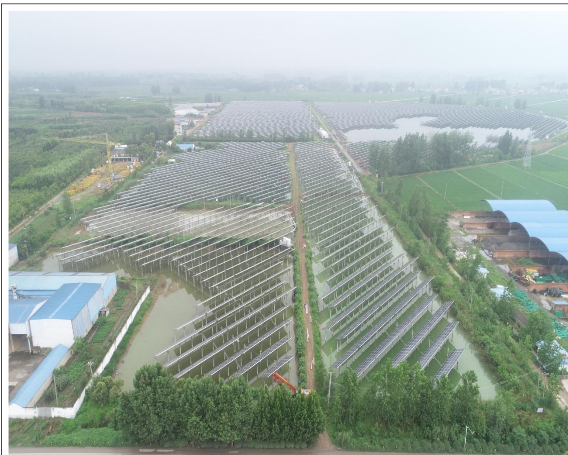
光伏场区现状 1
