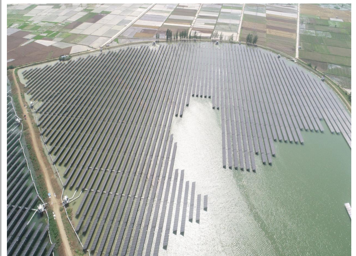
光伏场区现状 2
