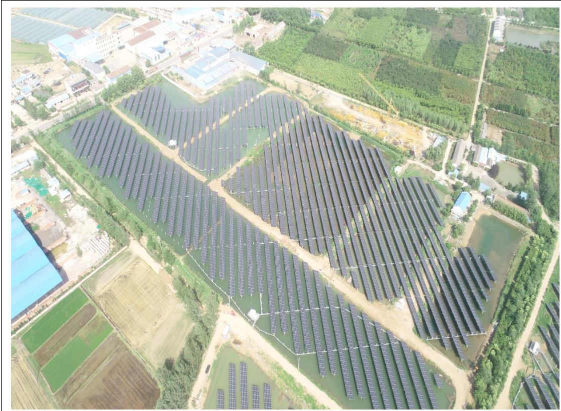
光伏场区现状 3
