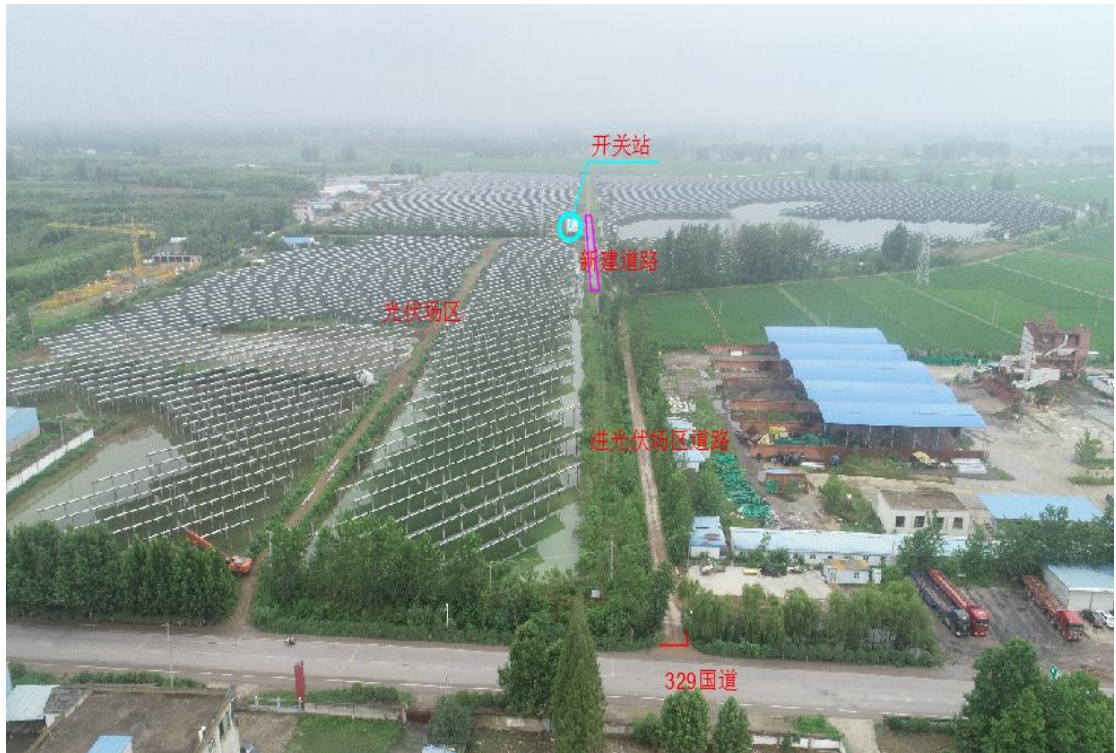
道路工程区现状
