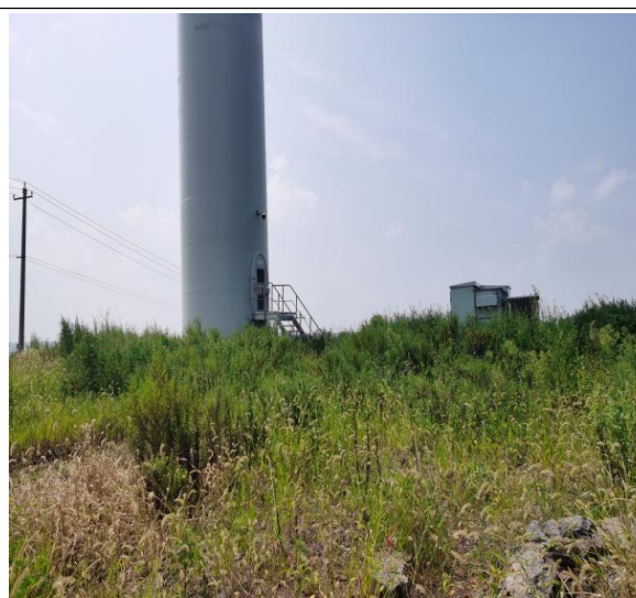
F12 号风机机组现状
