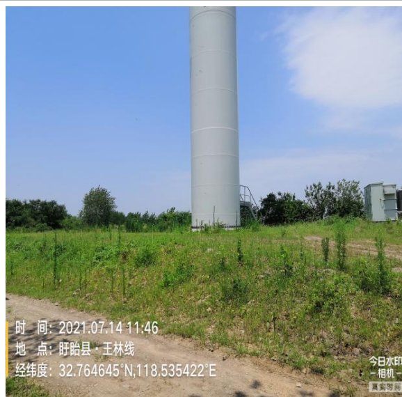
F04 号风机机组现状
