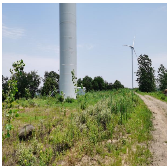
F03 号风机机组现状
