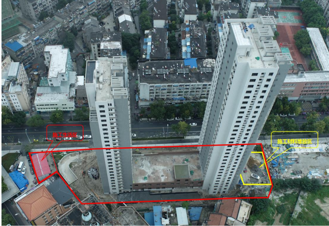
图 1.6 本项目施工生产生活区所在位置
