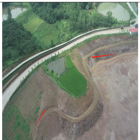
临时土方周转场
