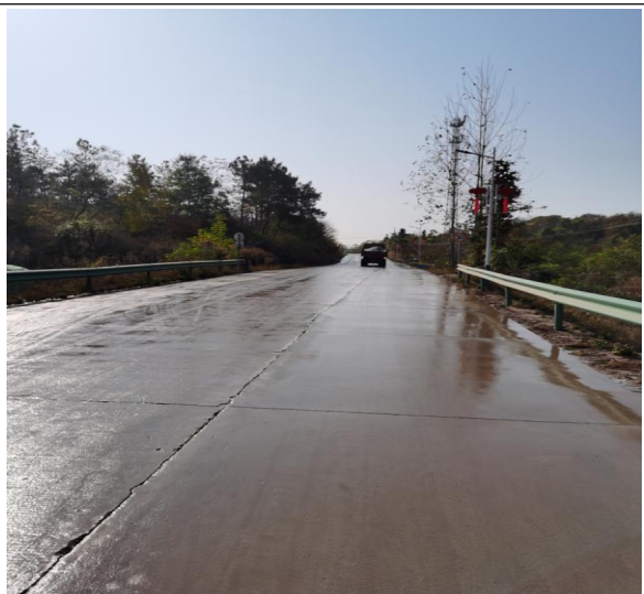
道路区（运输道路）
