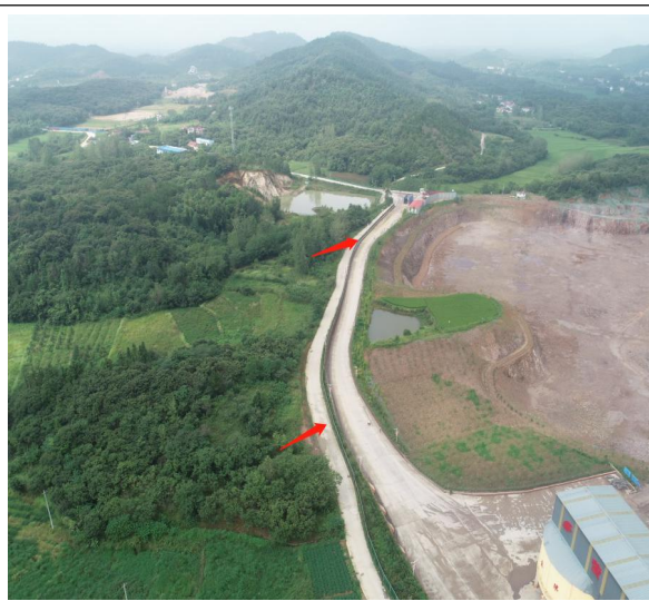
道路区（场内道路）
