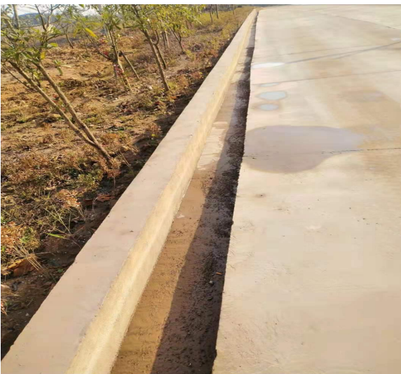
场内道路一侧排水沟
