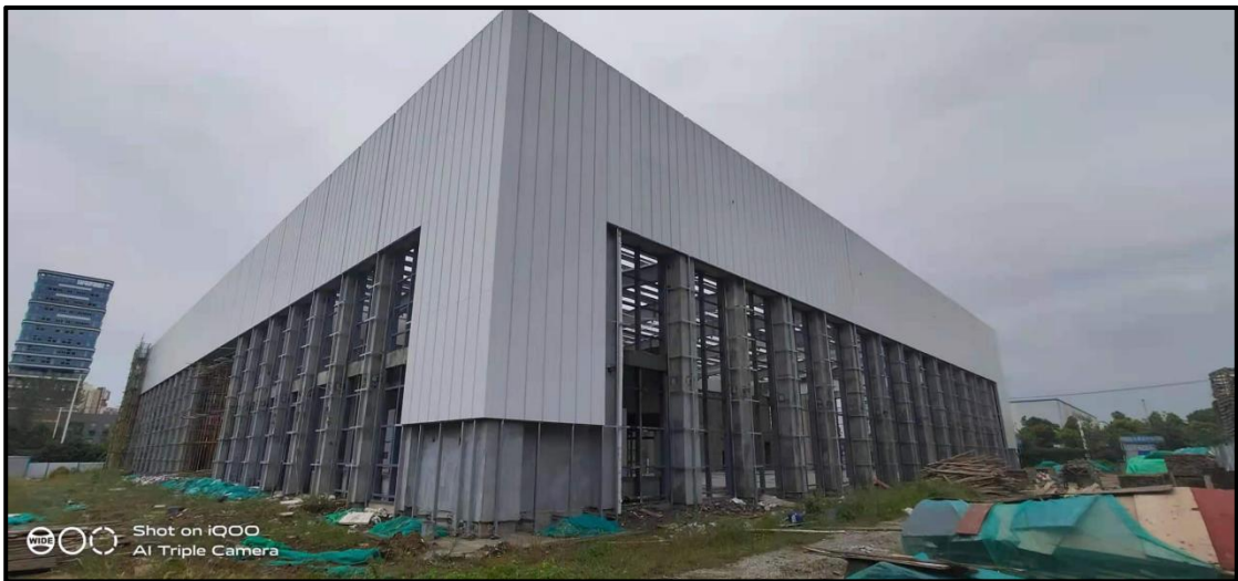
图 1.3-2 项目区现状图片
