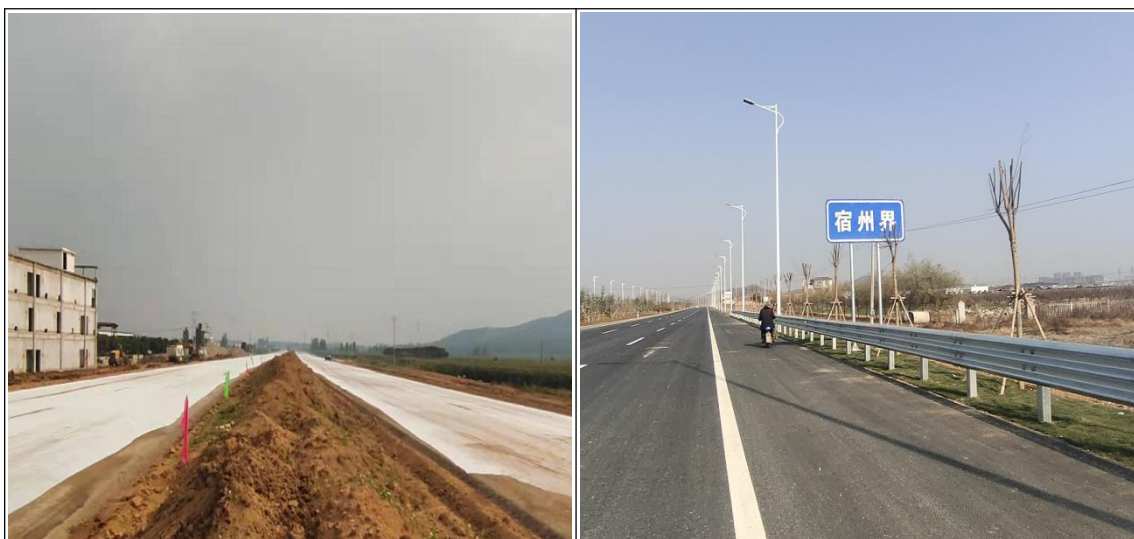
路基平整压实
