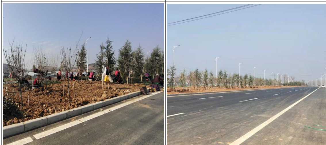
道路中央分隔带绿化
