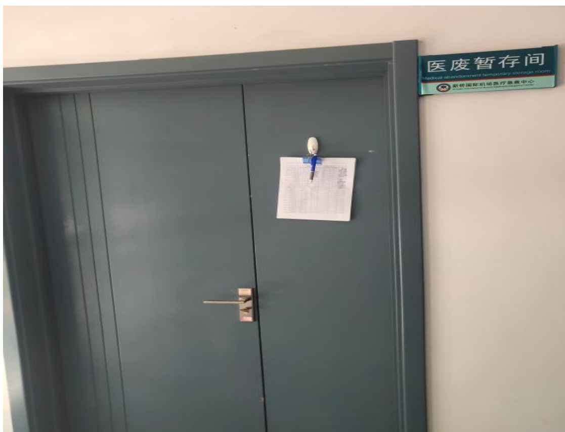
图 4-6 医疗废物暂存间
