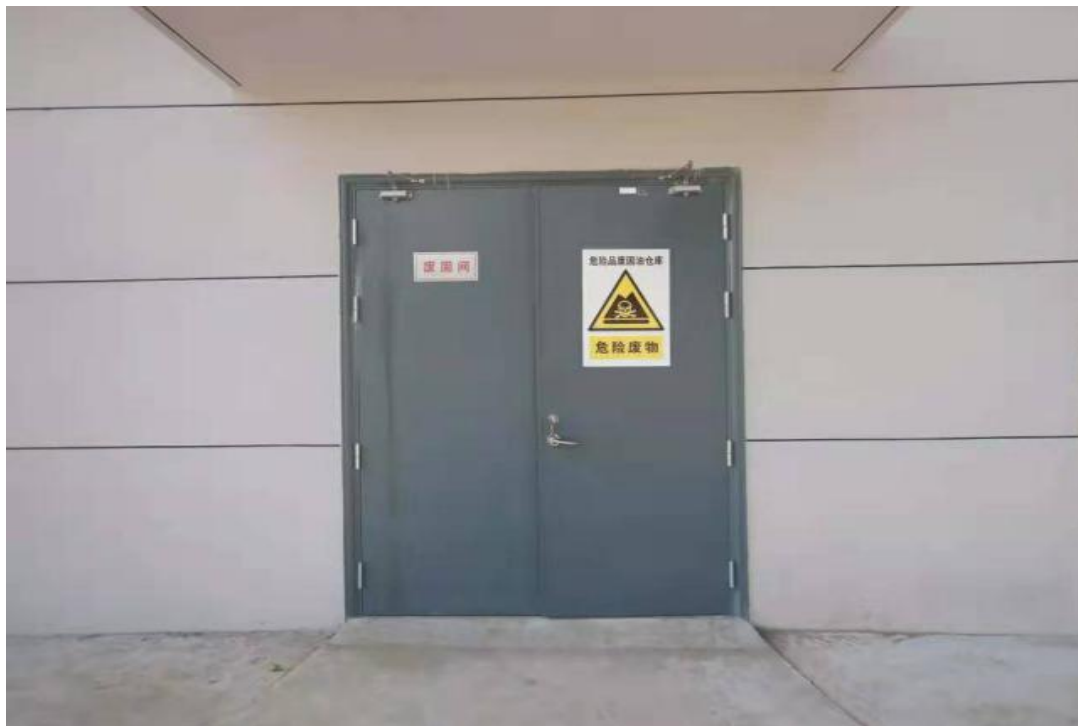
图 4-3 油库危废暂存库
