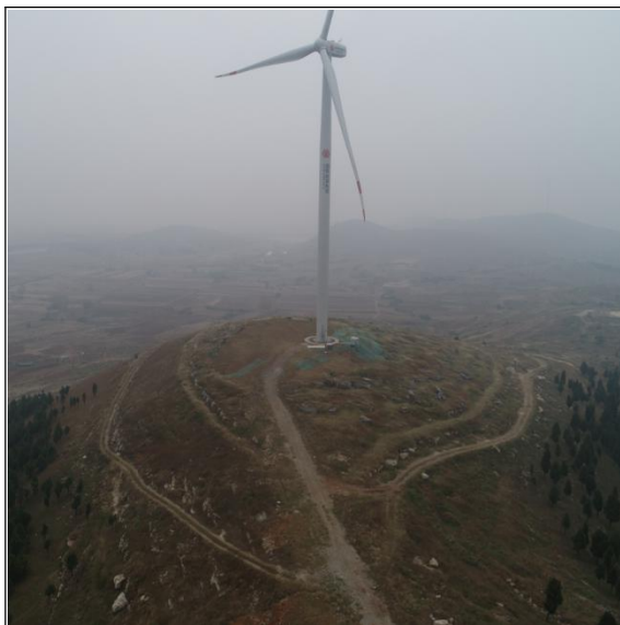
B3 风机机组 现状
