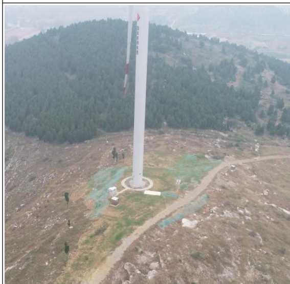
B5 风机机组 现状
