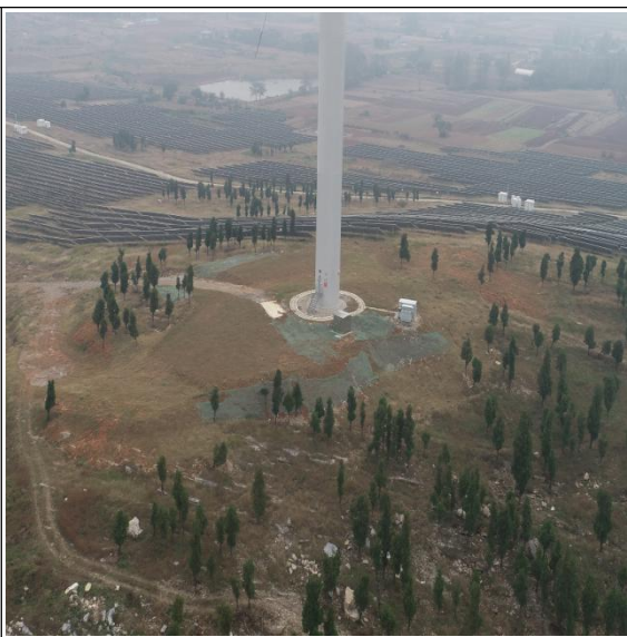
B4 风机机组 现状
