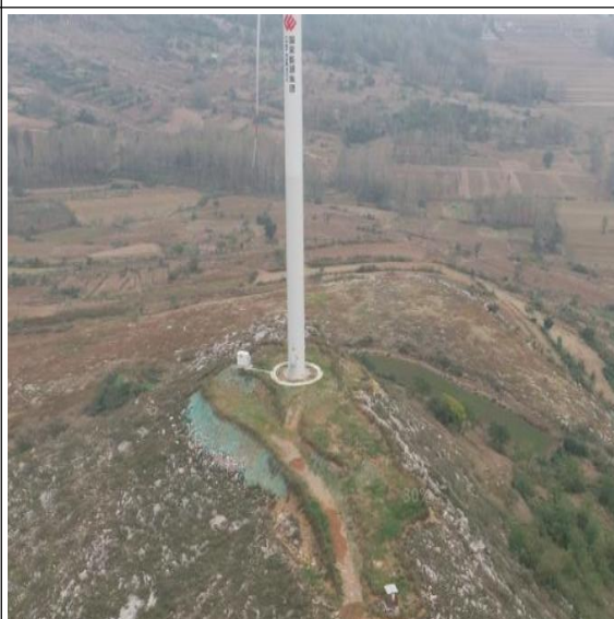
B8 风机机组 现状
