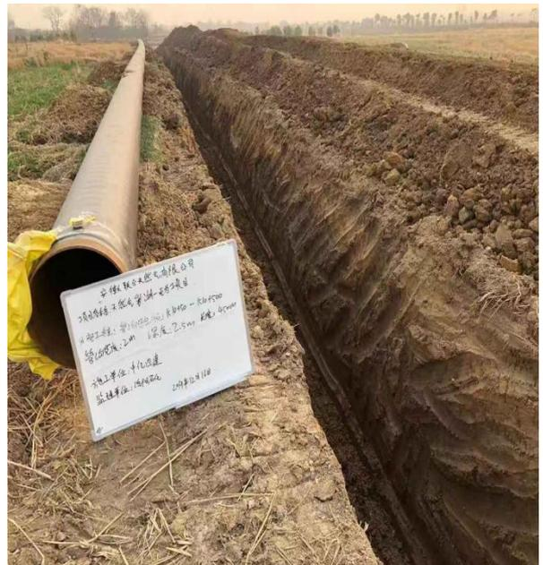
管线作业区开挖及临时堆土照片
