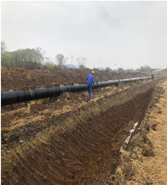
管线作业区开挖及临时堆土照片
