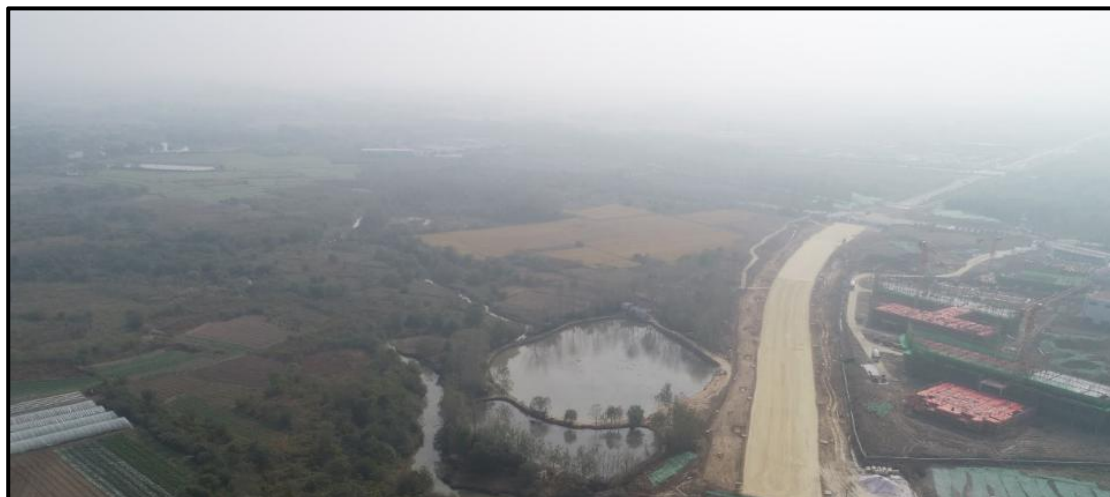
图 1.3-2 项目区现状图片
