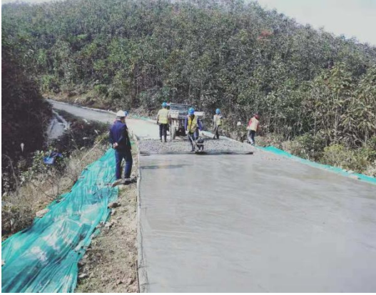
升压站站前道路砼浇筑
