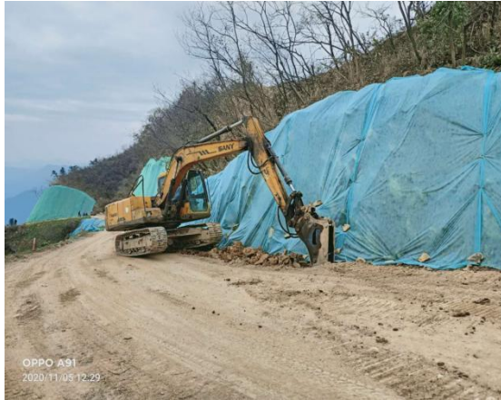
施工期堆土覆盖
