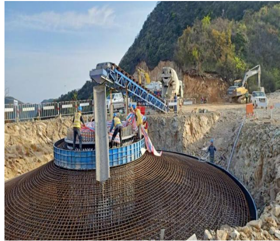
风机基座浇筑
