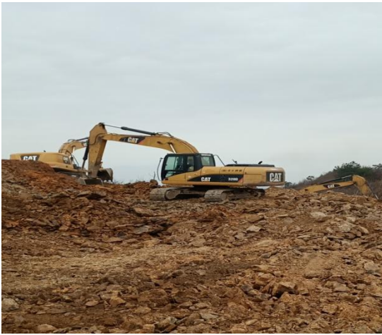
风机基座开挖
