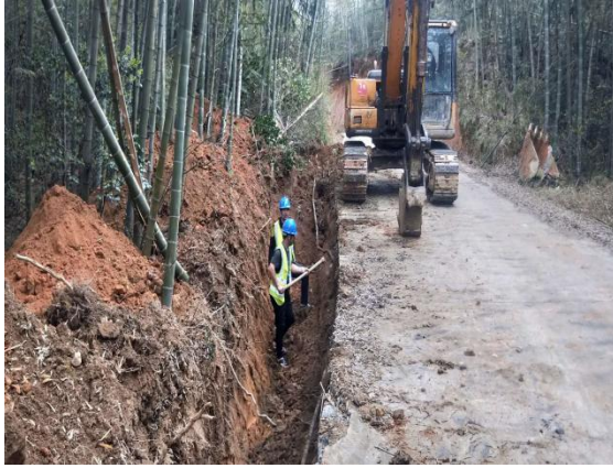
集电线路电缆沟开挖
