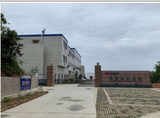
升压站建设情况
