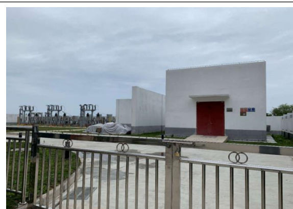
升压站建设情况
