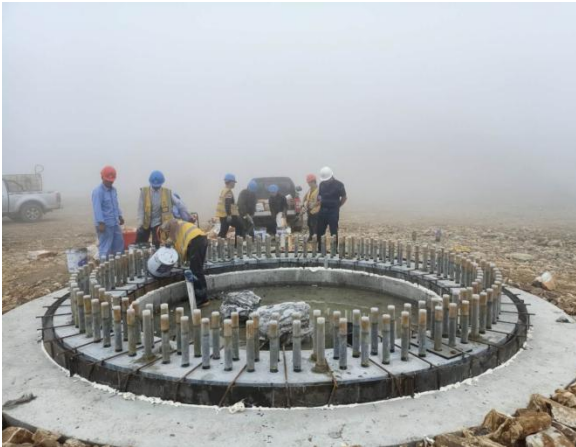
风机二次灌浆
