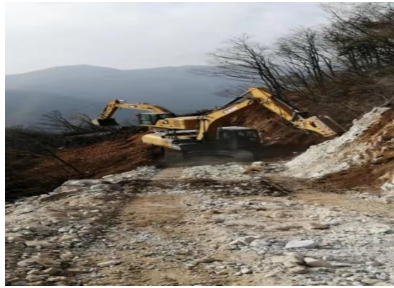
进场道路加宽
