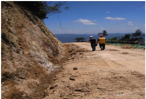
集电线路电缆沟验收
