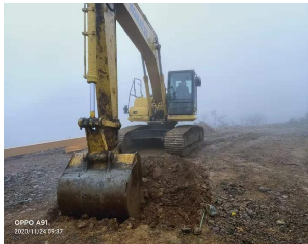
箱式变压器基础开挖
