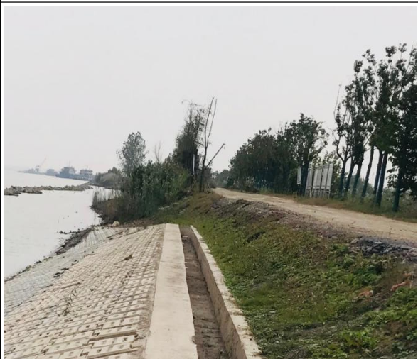
道路边坡绿化
