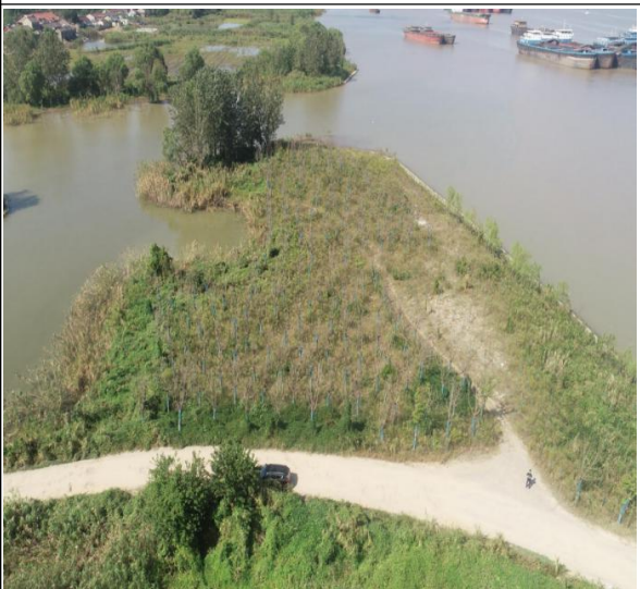
施工场地绿化
