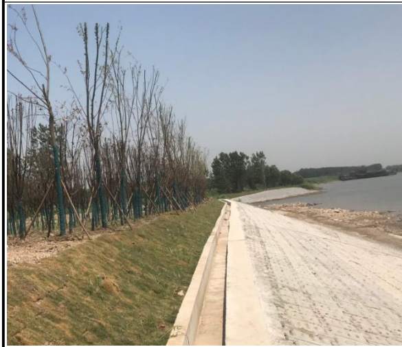
道路边坡草皮护坡
