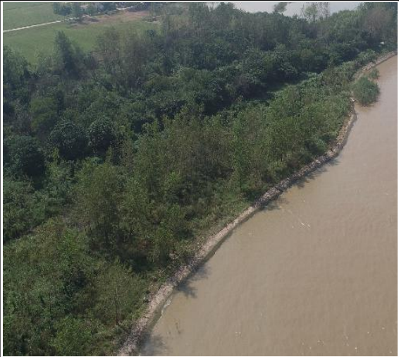
江心洲头~左缘小新滩施工道路现状
