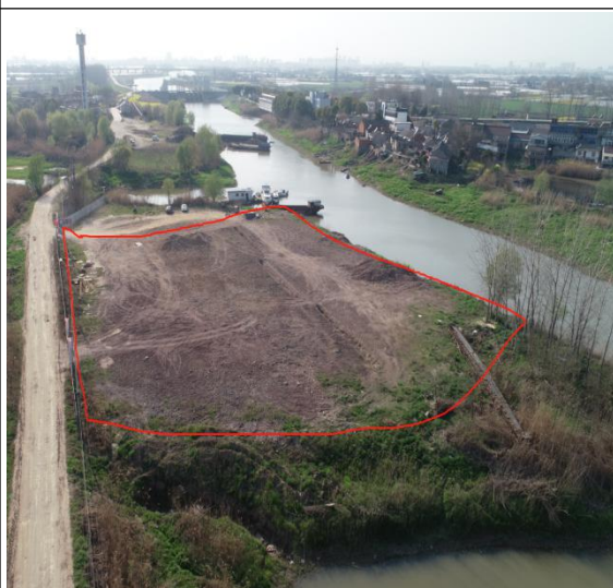
施工场地监测过程照片
