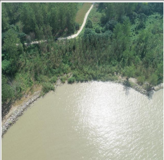
江心洲左缘 I 段崩岸治理段现状
