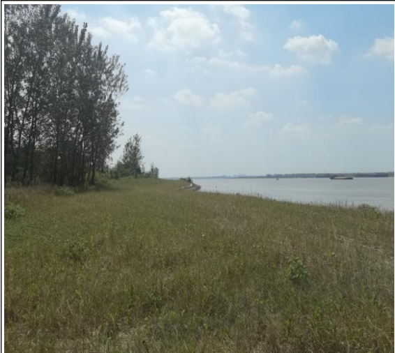
江心洲尾施工道路现状
