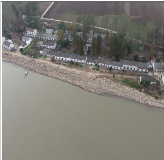
彭兴洲右缘 I 段监测过程照片
