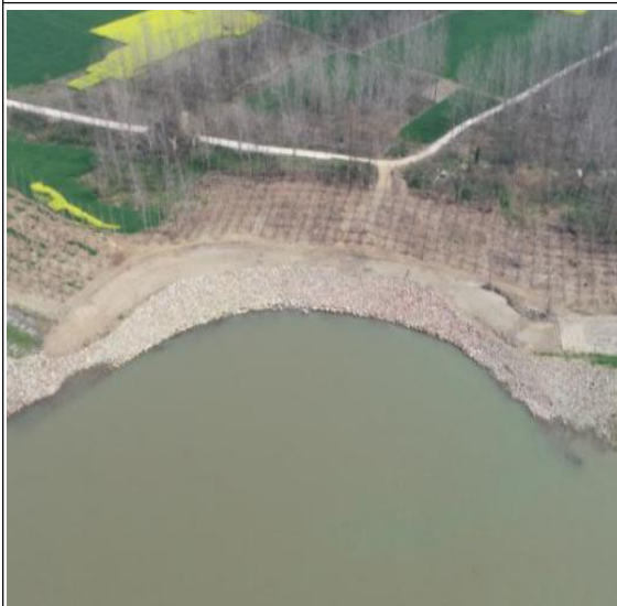
江心洲左缘 I 段崩岸治理段监测过程照片
