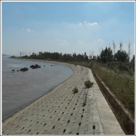
新河口 ~ 金河口护岸及排水沟现状
