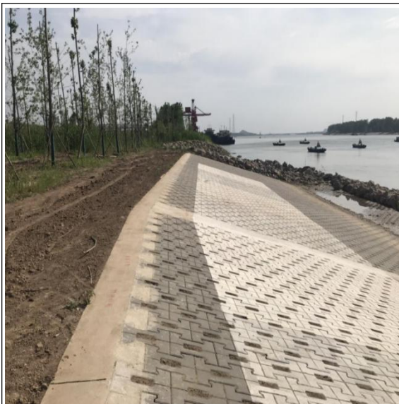
腰坦池新护水上护坡监测过程照片
