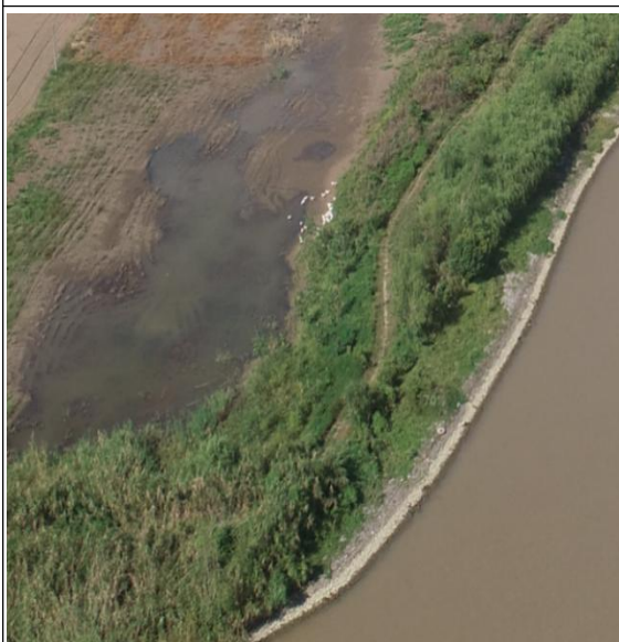
大黄州尾施工道路现状
