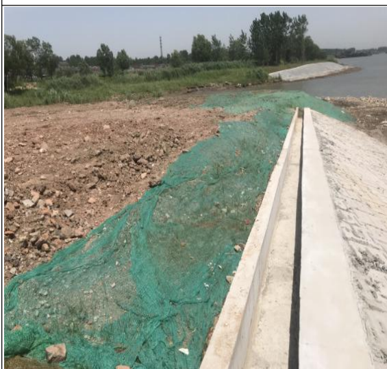
施工场地监测过程照片
