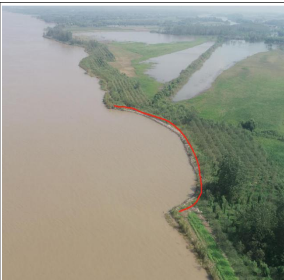
江心洲左缘 II 段崩岸治理段现状
