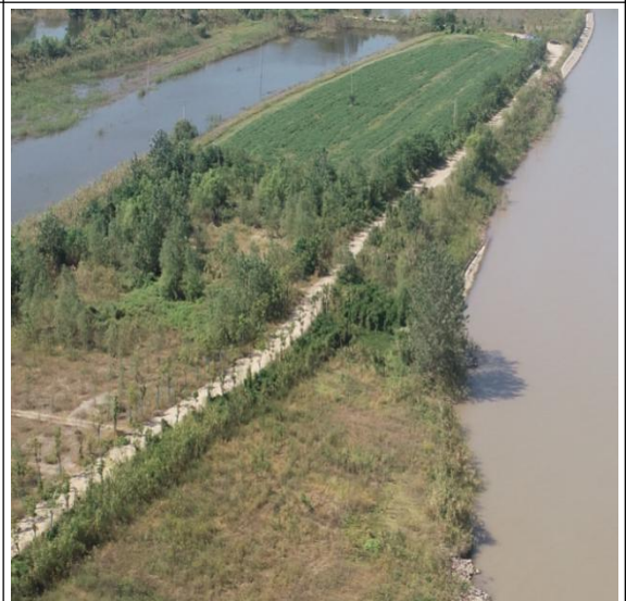
新河口~金河口加固段施工道路现状
