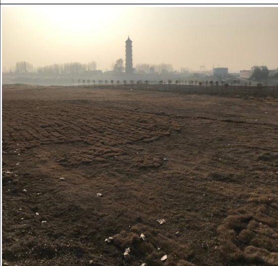
施工场地监测过程照片
