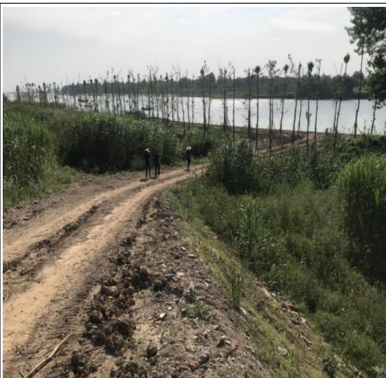
临时施工道路监测过程照片
