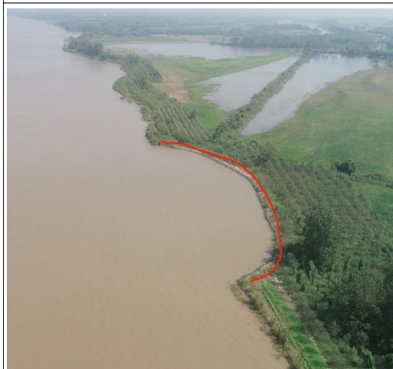
江心洲左缘Ⅱ段崩岸治理段现状
