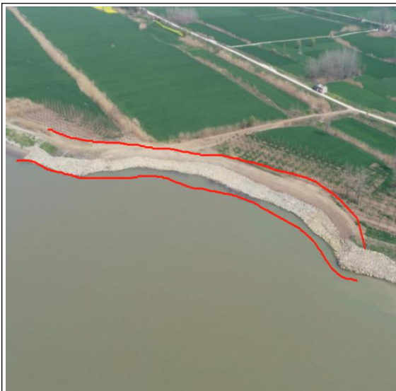
江心洲左缘 II 段崩岸治理段监测过程照片
