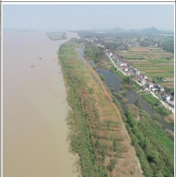
江心洲左缘大桥下新护 1800m 现状
