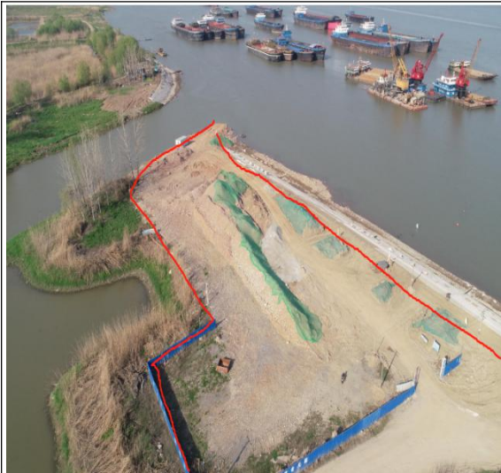
施工场地监测过程照片
