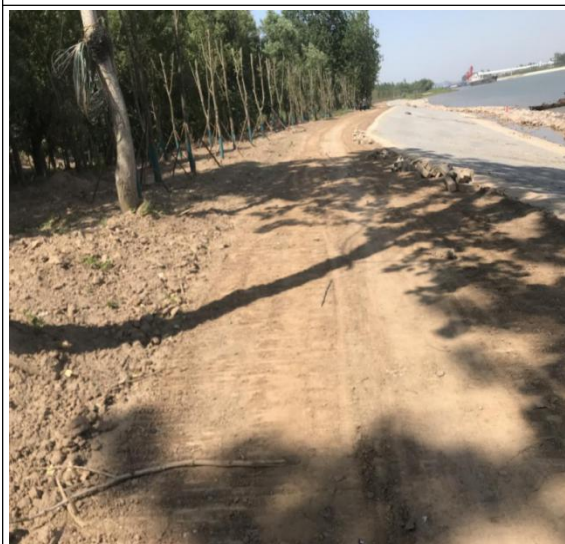
护坡顶后方临时道路监测过程照片
