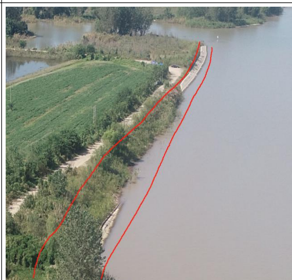
新河口~金河口段现状
