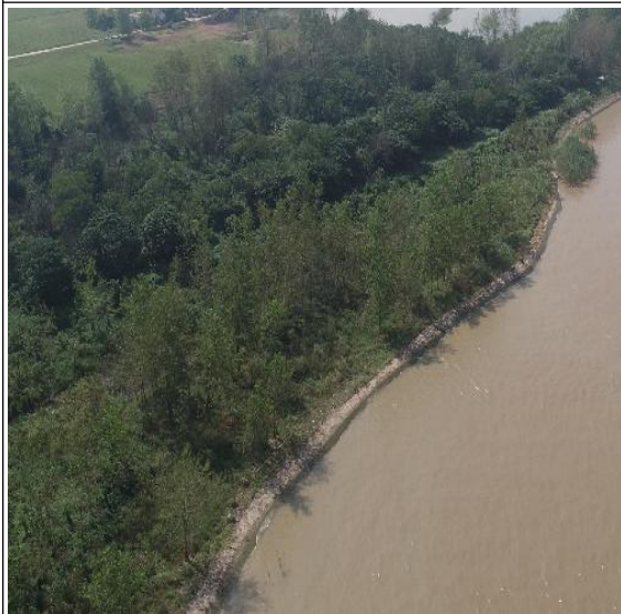
江心洲头~左缘小新滩施工道路现状
