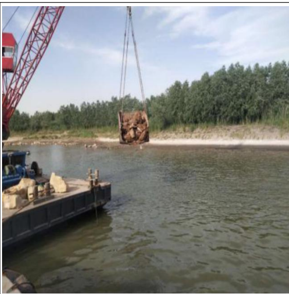
江心洲左缘崩岸治理水下抛石监测过程照片
