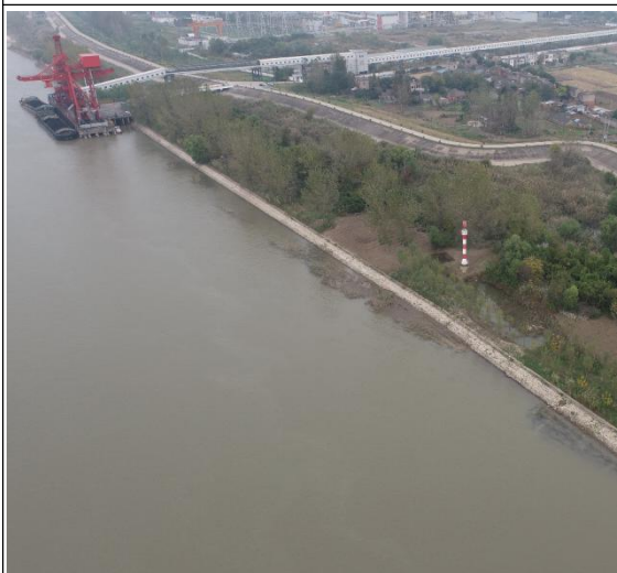
腰坦池新护段监测过程照片
