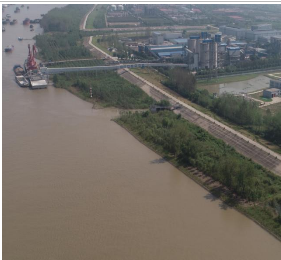
腰坦池新护段现状
