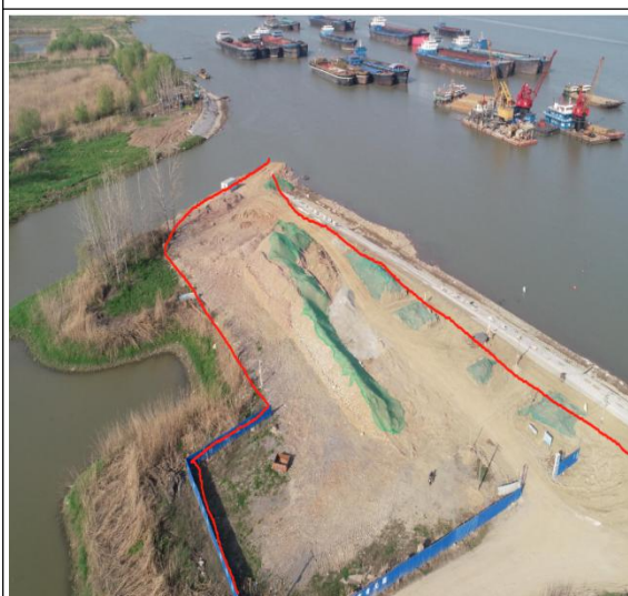
施工场地监测过程照片
