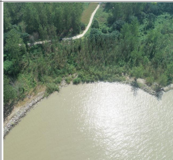
江心洲左缘Ⅰ段崩岸治理段现状
