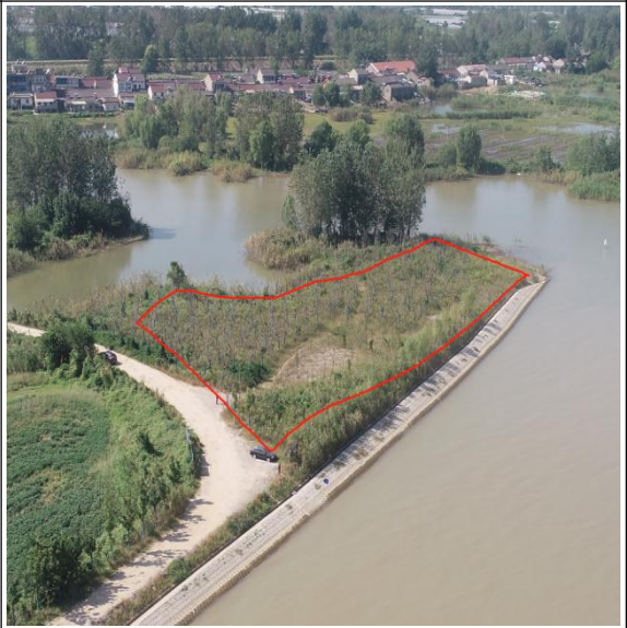
施工场地现状
