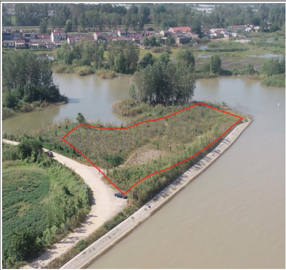
施工场地现状
