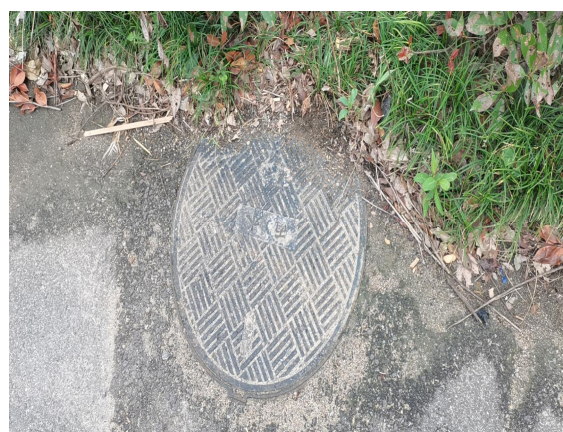
项目现状雨水管网
