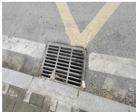
项目现状雨水管网
