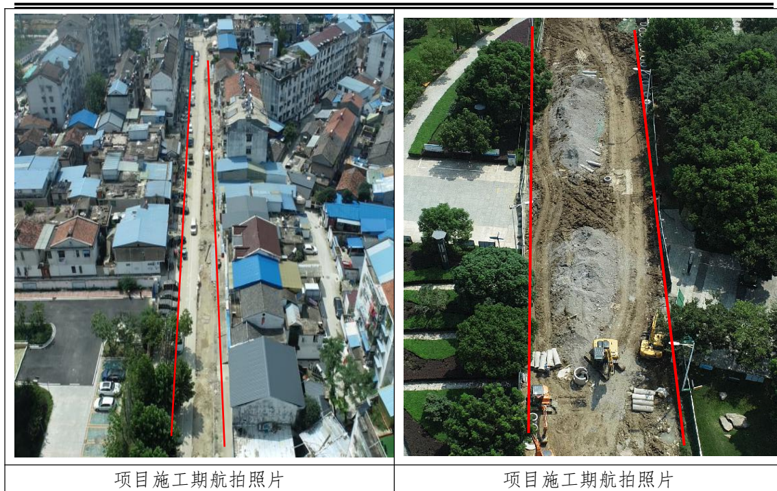
图 1.7-2 项目区现场图片
