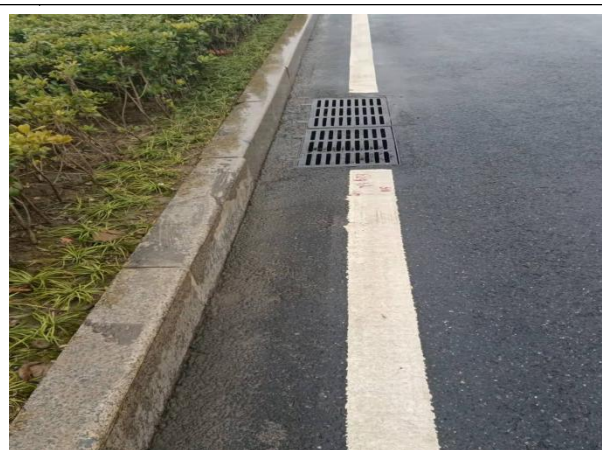
项目现状雨水管网
