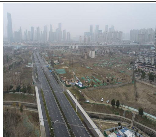
桥梁工程区绿化
