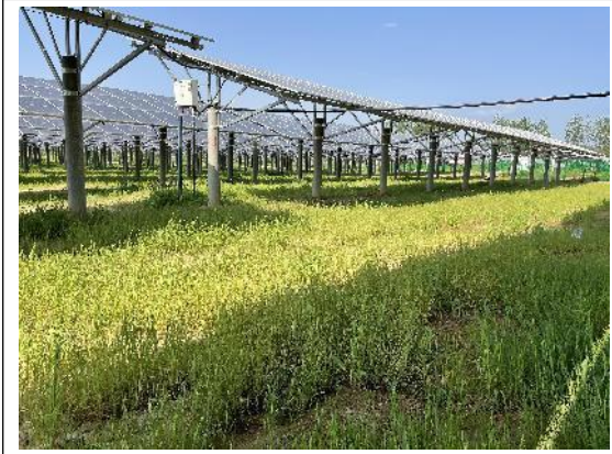
光伏区绿化恢复
