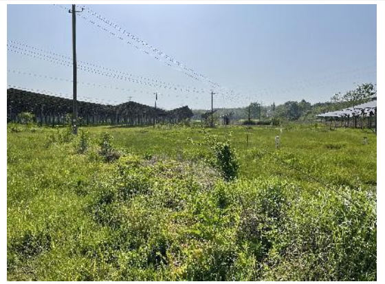
光伏区绿化恢复
