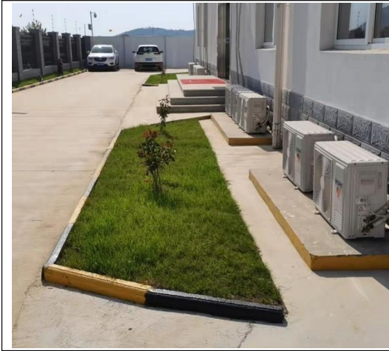
升压站绿化恢复
