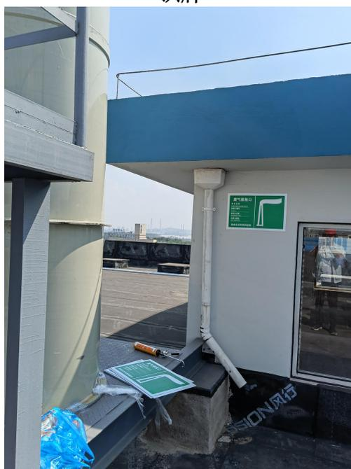
图 4-17-4 实验室废气排放口标识牌
