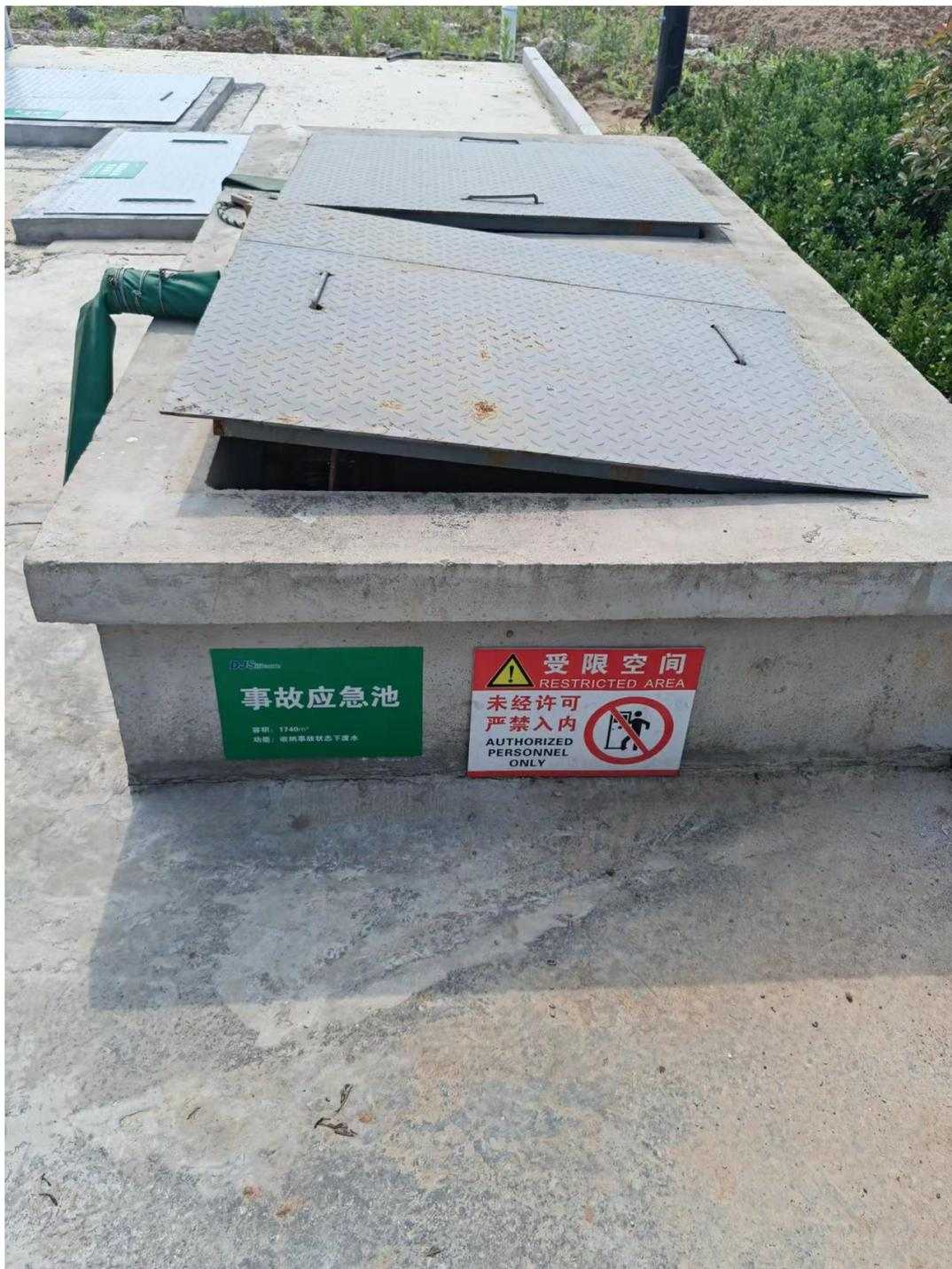
图 4-14 事故水池（尺寸 29m×15m×4m）
