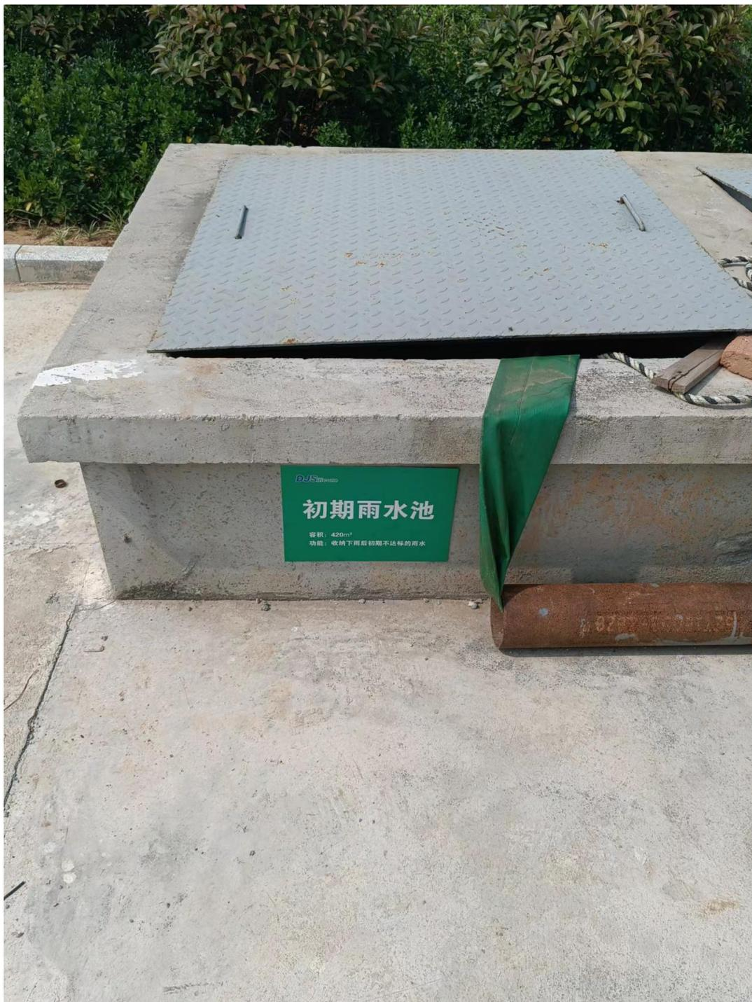
图 4-15 初期雨水池（尺寸 7m×15m×4m）
