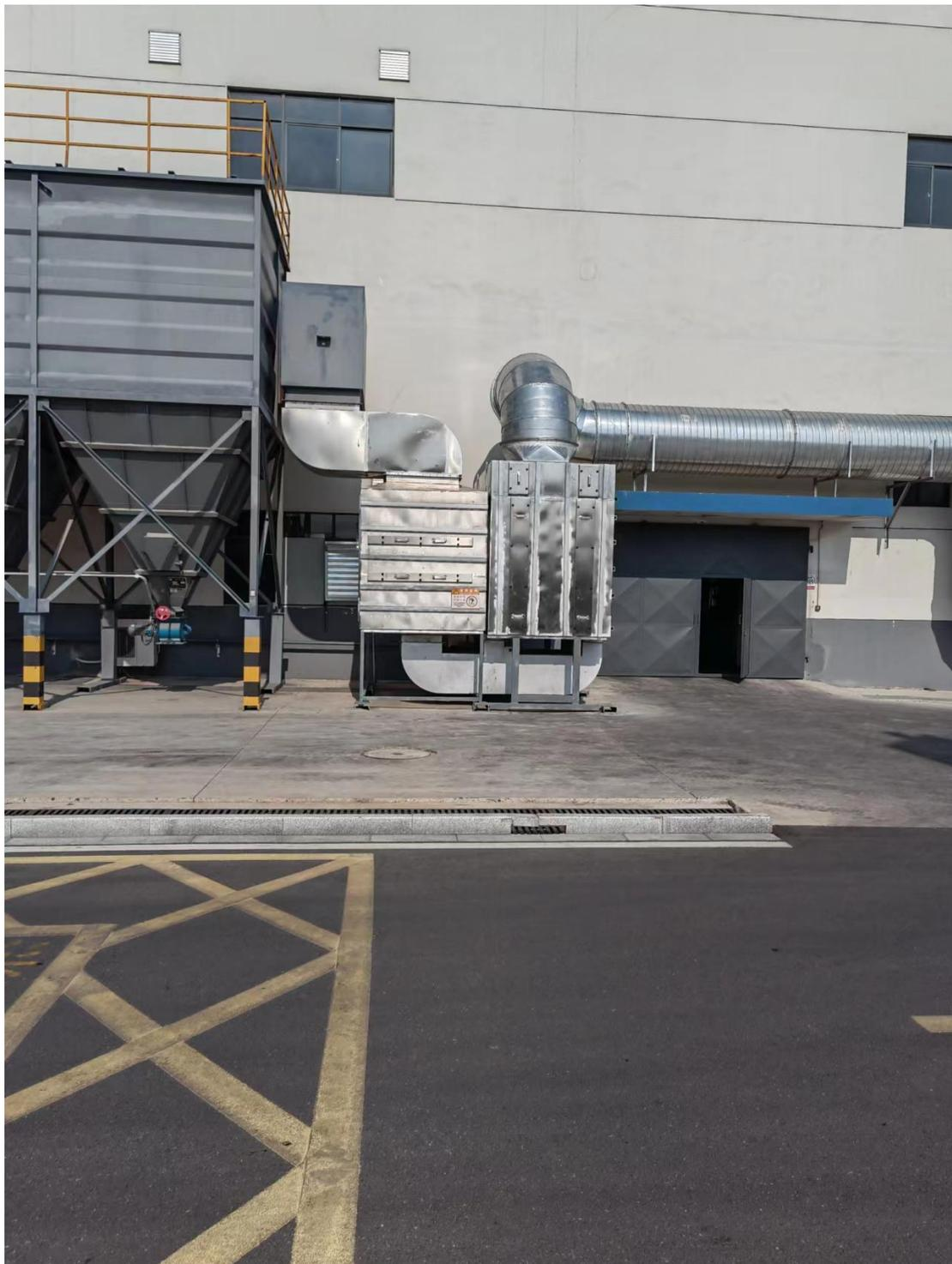
图 4-4 混炼胶工艺废气治理设施
