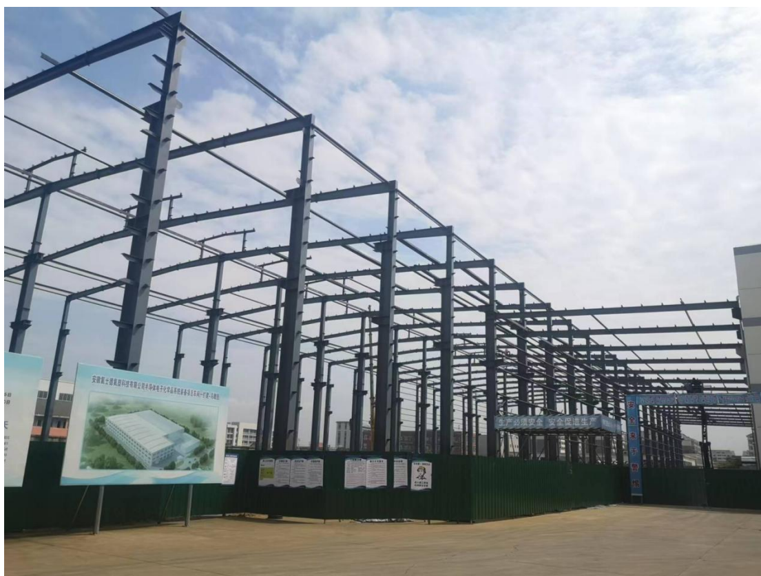
图 1.3-2 项目区在建工程区现状图片
