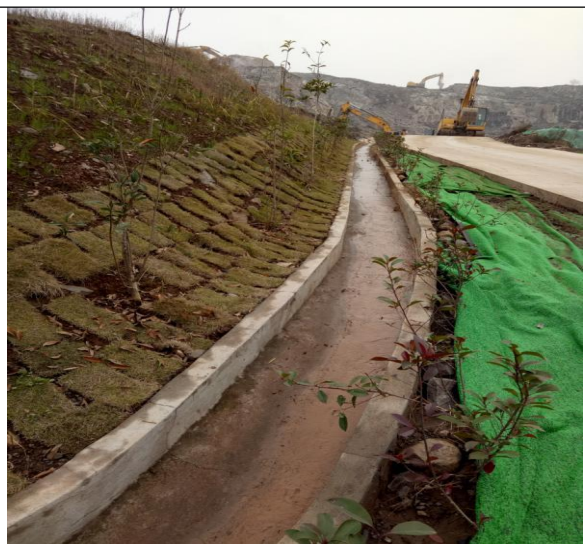
道路一侧排水沟
