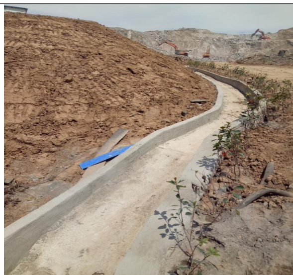
临时土方周转场施工前
