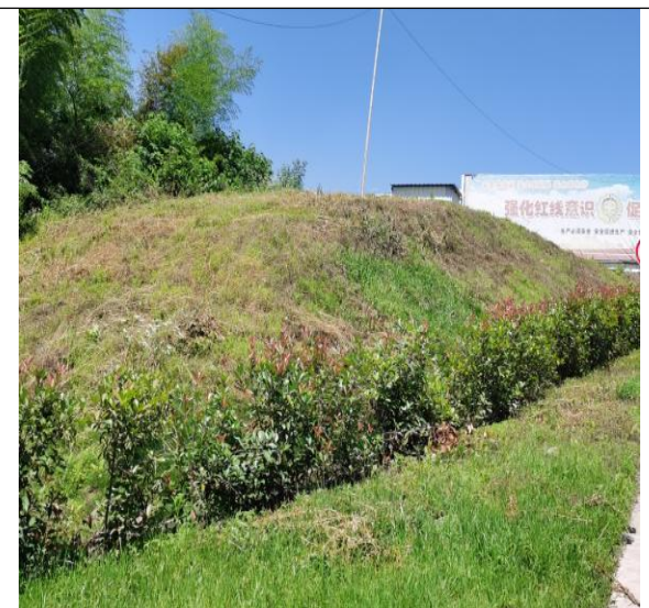
临时土方周转场现状
