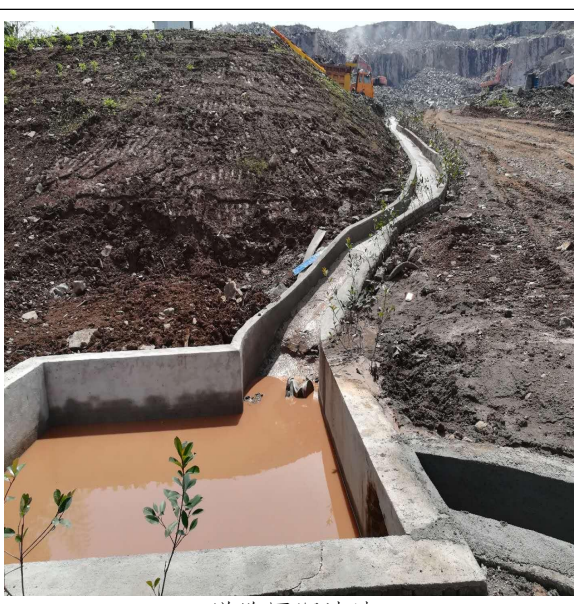
道路区沉沙池
