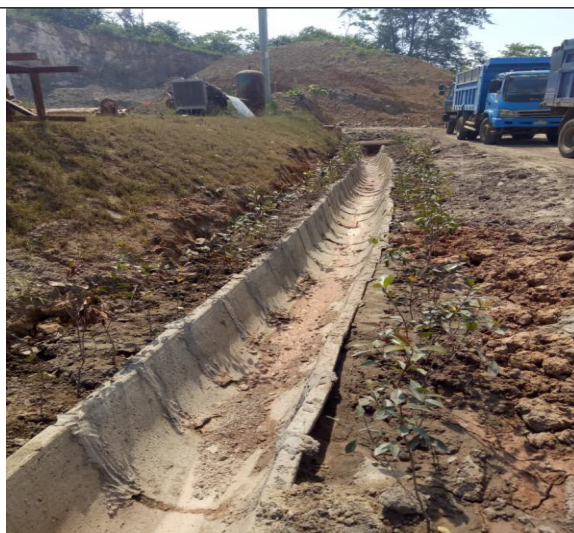
道路旁排水沟
