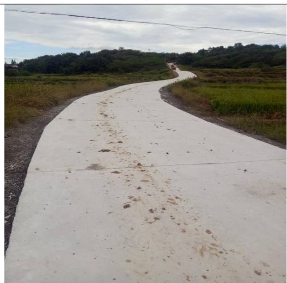
道路区（运输道路）
