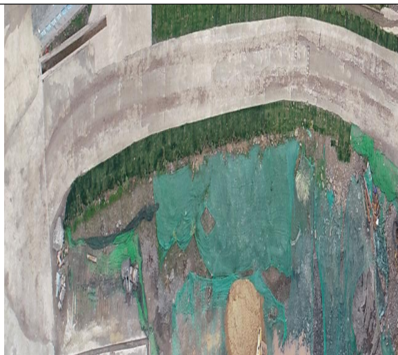
道路区（场内道路）
