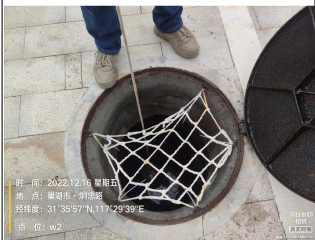
项目现场污水取样监测
