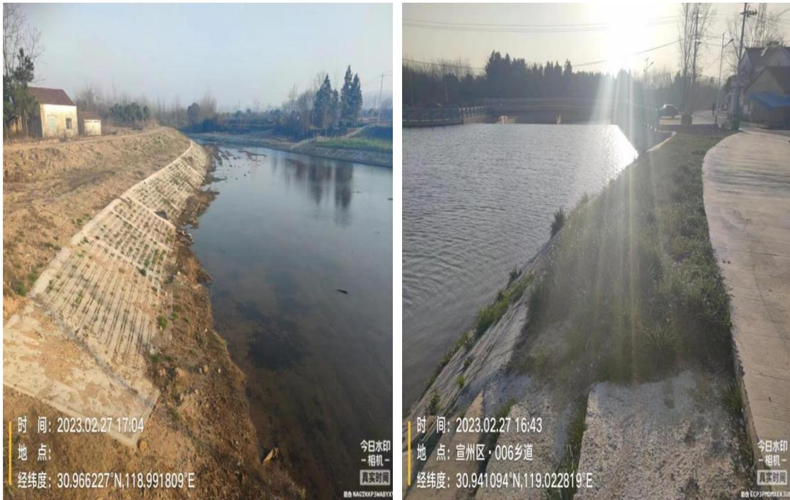
图 7-11 新建生态护岸
