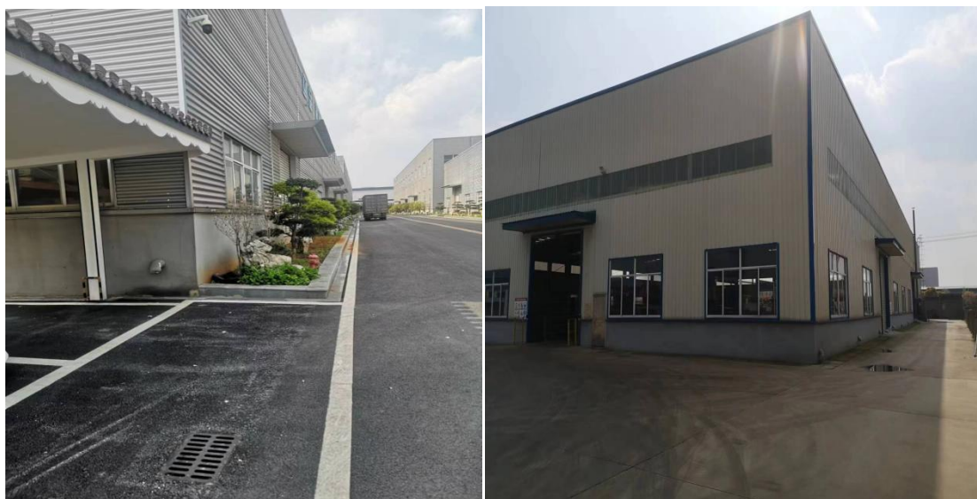
图 1.5-2-2 已建工程区排水管网现状
