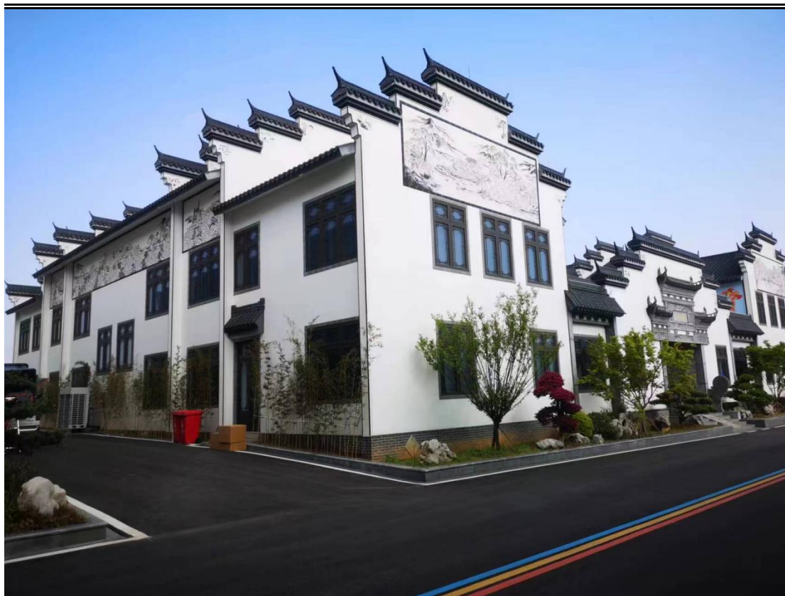
图 1.3-2 项目区现状图片
