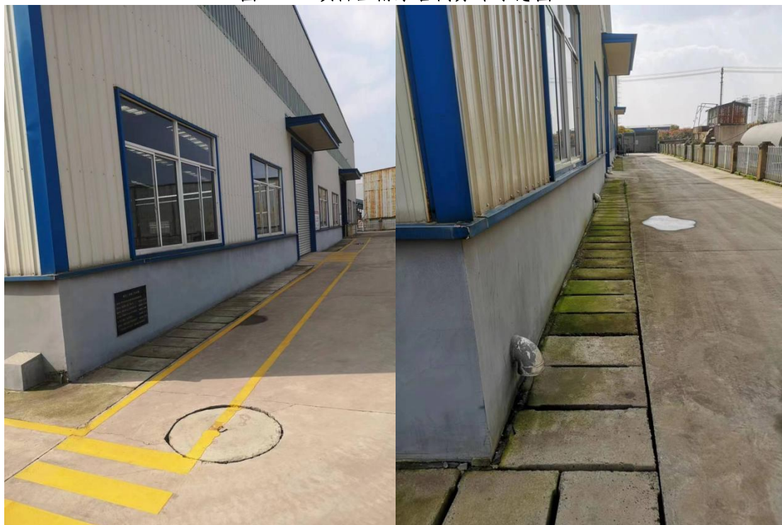
图 1.5-4 项目雨水管网及盖板排水沟现状
