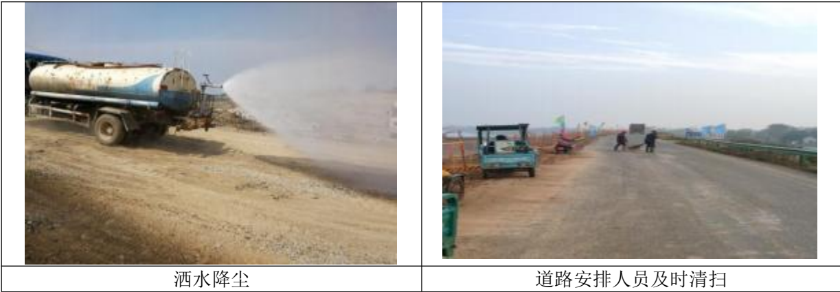
图5.3-1 施工期环境空气调查
