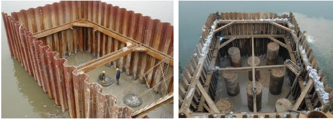
图 3-35 围堰施工图
