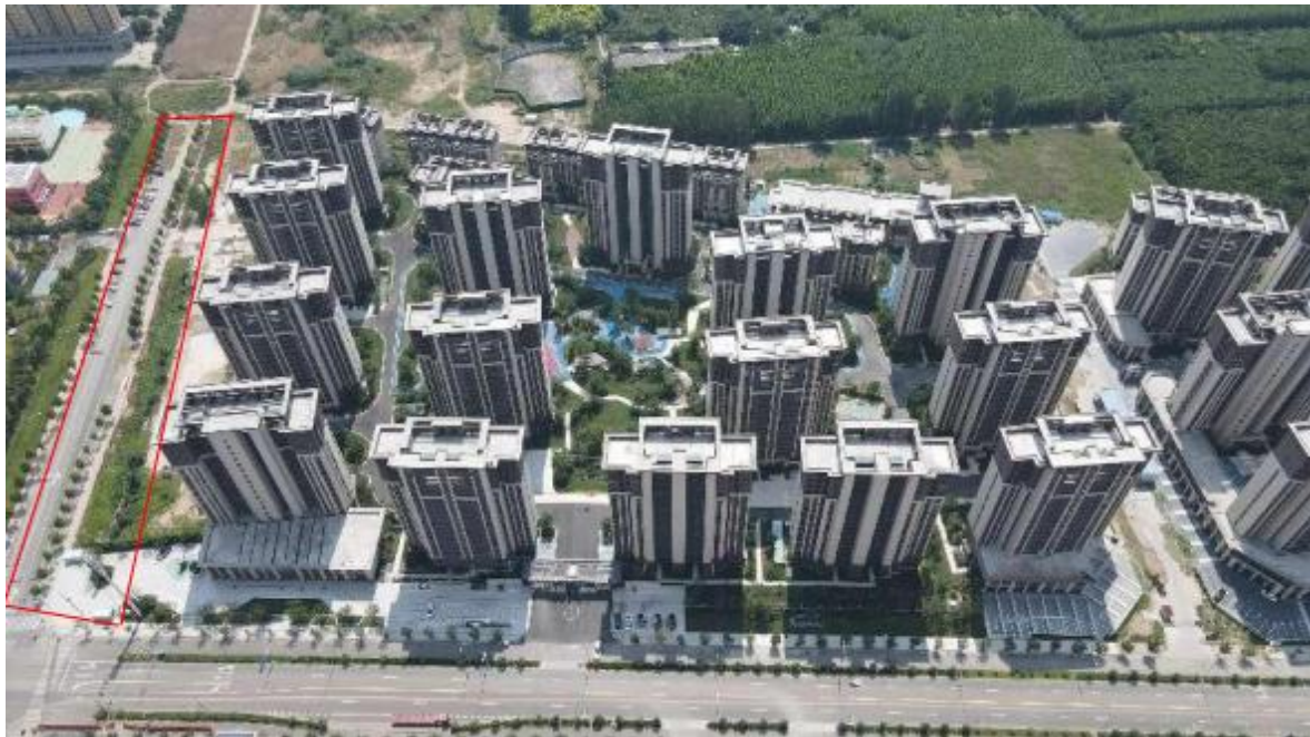
图 1-4 施工场地现状图
