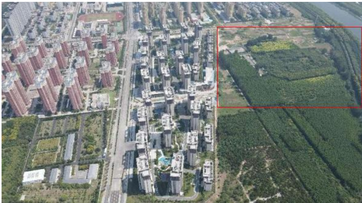
图 1-5 临时堆土区现状图
