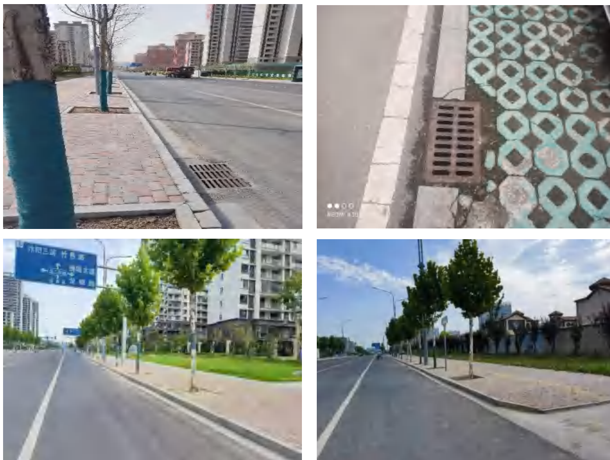
工程措施与植物措施现照片
