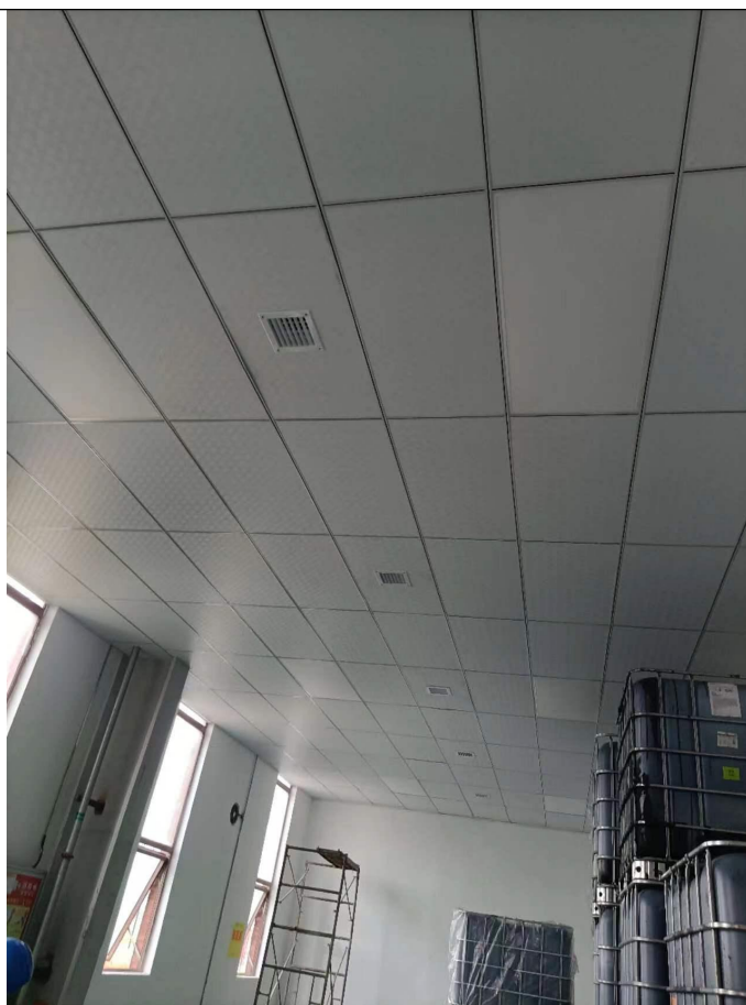
图 3-8 危废库顶部微负压废气收集
