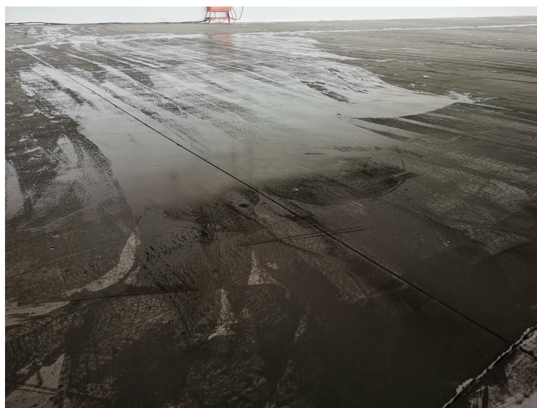
图 4-3 地面防渗措施
