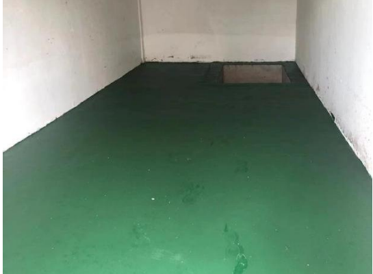
危废暂存间内部
