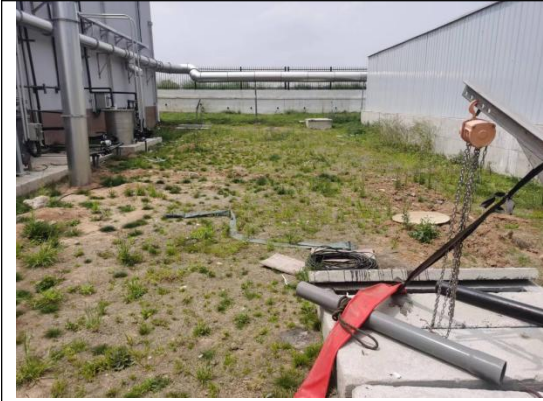
事故应急池（含初期雨水池、地埋式）
