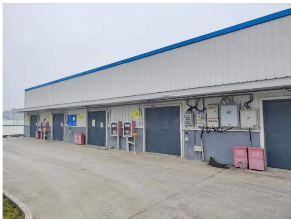
图 4.1-8 危废暂存仓库
