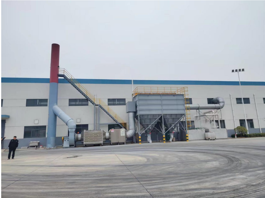
图 4.1-4 绝缘胶工艺废气治理设施
