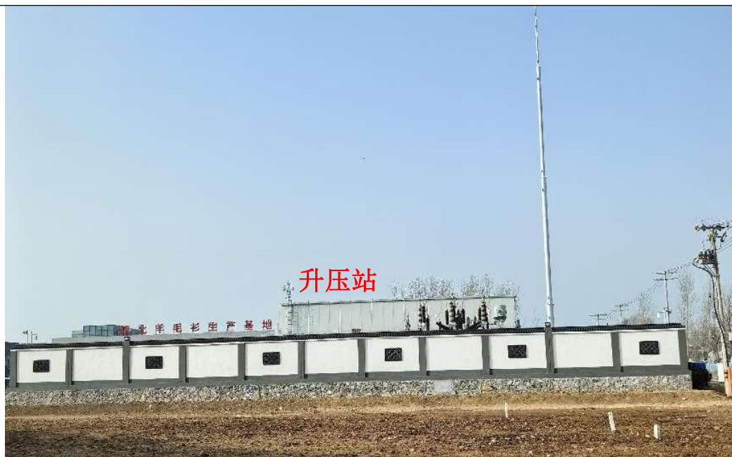
图 4-2 110kV 光伏升压站现状图
