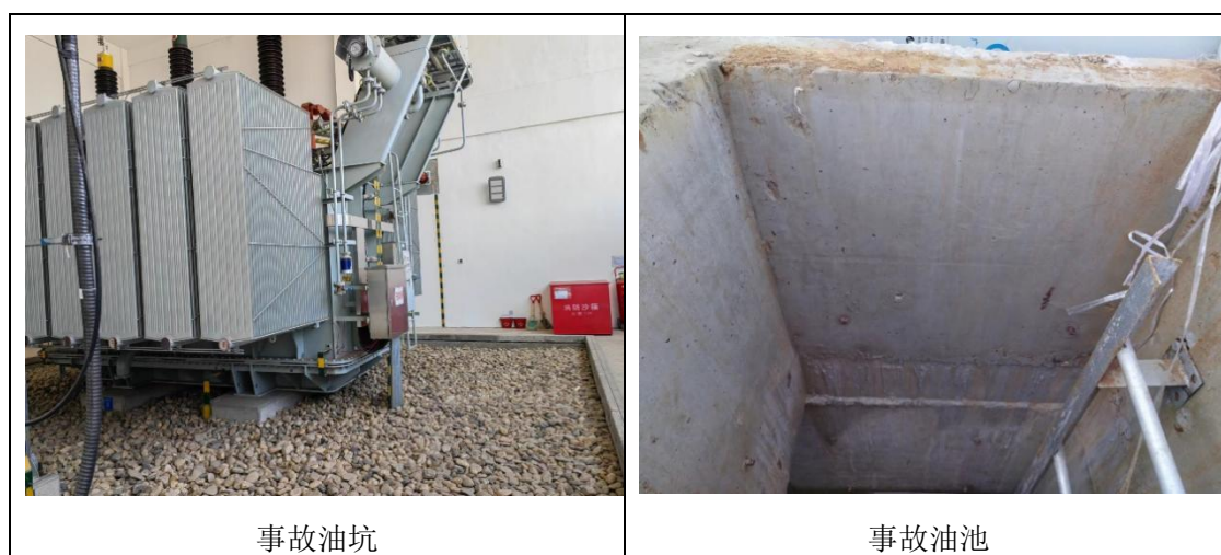
图 4-2 事故油池现状图
