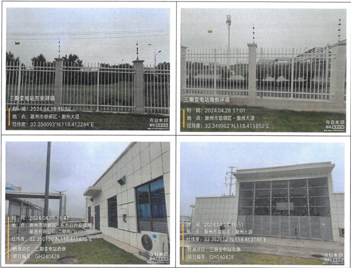
附图 3: 变电站四周照片
