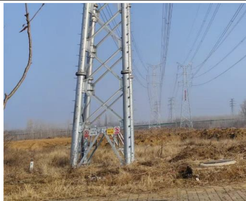
塔基恢复现状
