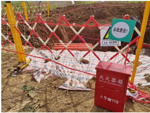
施工现场苫盖、围挡措施
