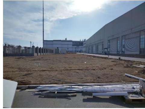
现场恢复照片
