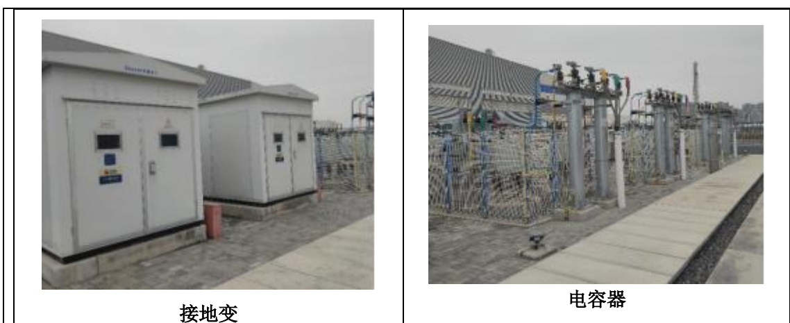
图 4-1 变电站现状图
