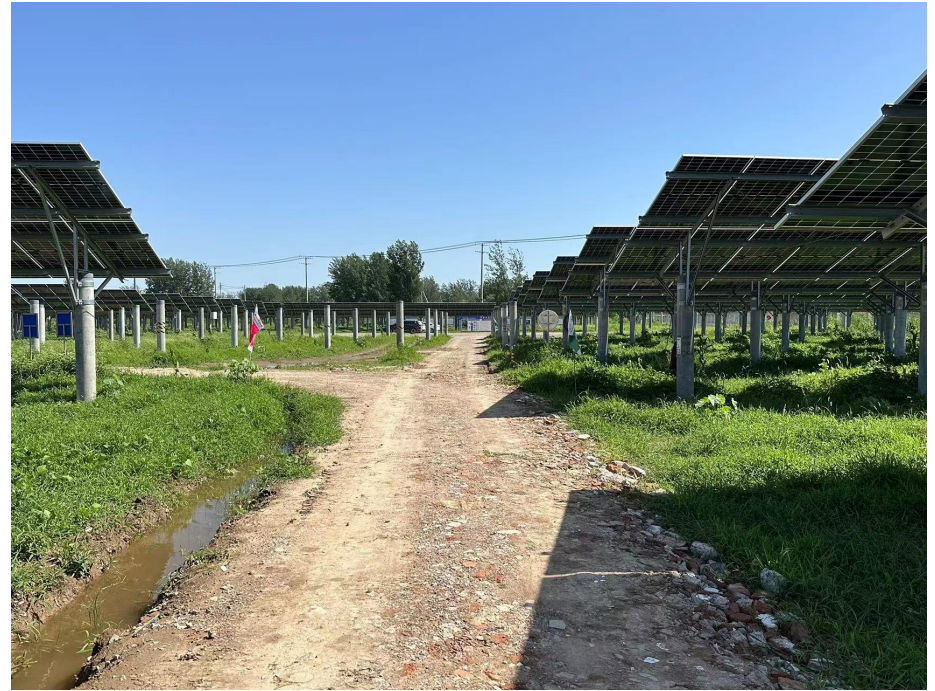
光伏区施工道路
