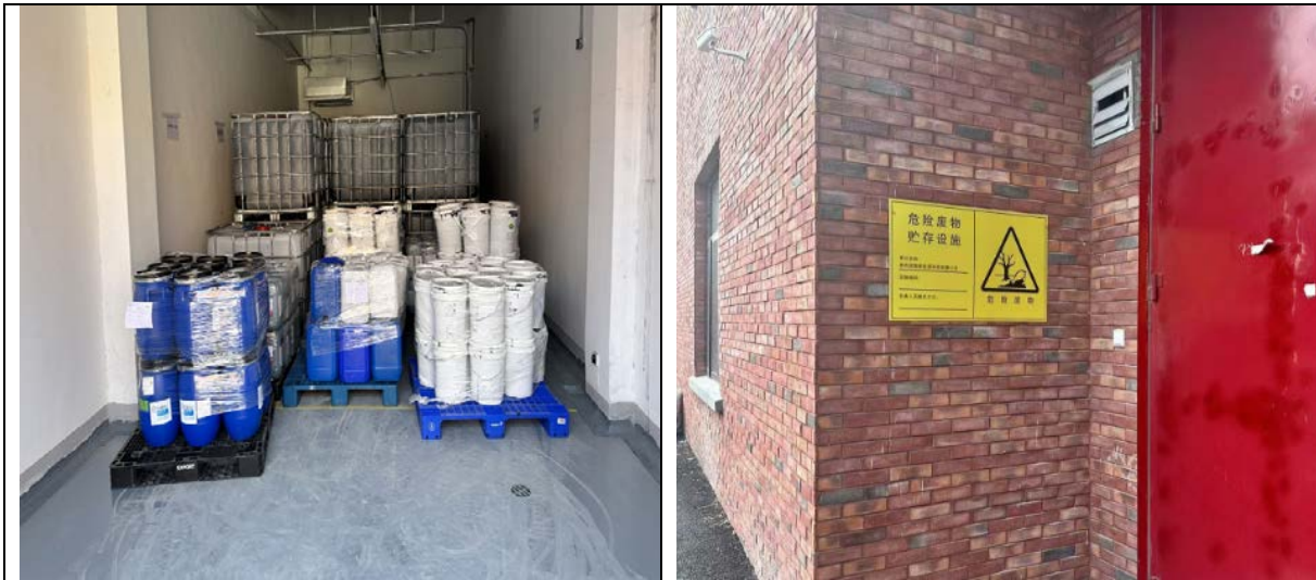
图 3-4 危废暂存设施
